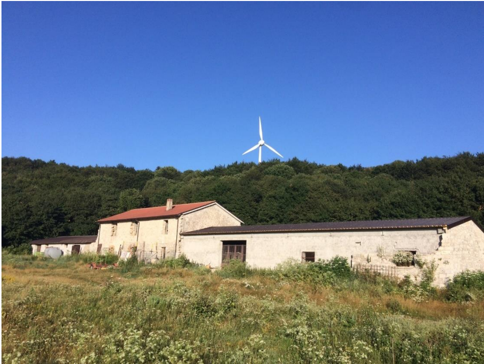
Figura 3.10: Struttura monitorata per la ricerca dei rifugi estivi dei chiroterri (Comune di Monteferrante)
