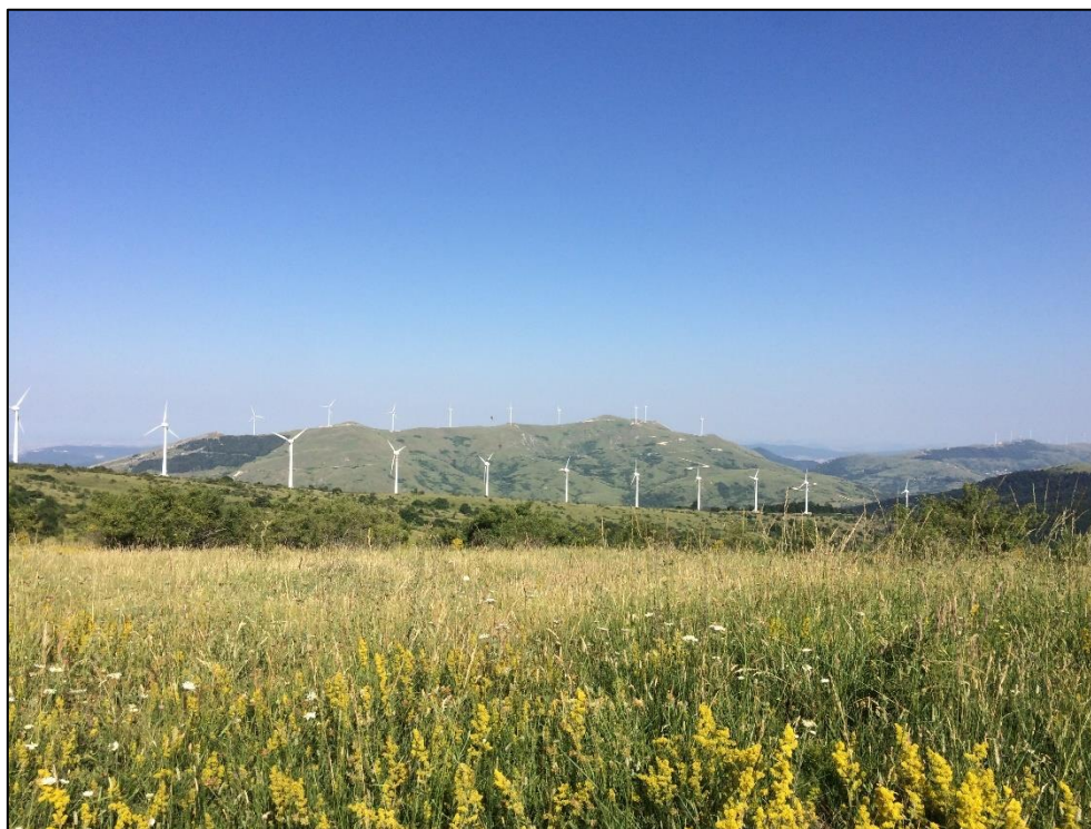
Figura 3.1: Dettaglio panoramico dell'impianto esistente (zona sud)
