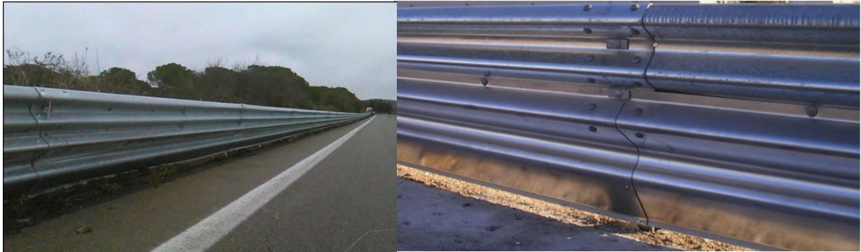
Barriera di classe H2 bordo laterale – Inserimento e dettaglio D.S.M.
