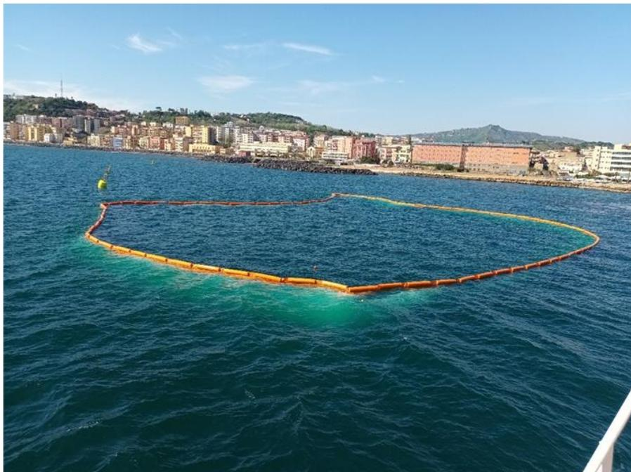
Figura 9-6: Posizionamento, dettaglio degli elementi galleggianti e delle relative maniche
