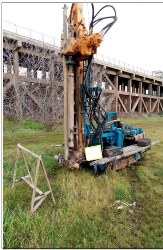
Figura 1- Attività di realizzazione sondaggi – sonda perforatrice
