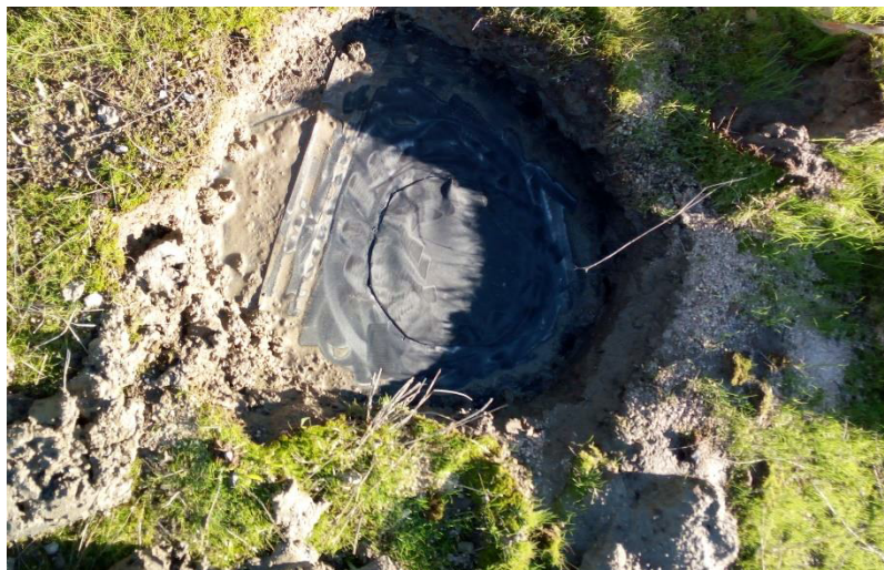
Esecuzione collegamento tra i teli
