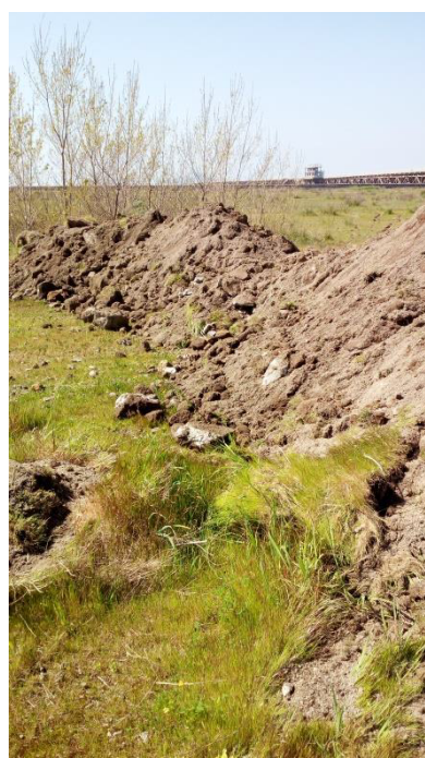
Verifica in fase di scavo della presenza di Amianto
