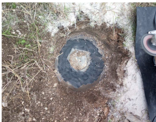
Pulizia con smerigliatrice del telo in opera
