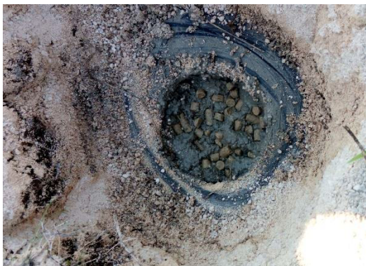
Scavo di pulizia e preparazione miscela di riempimento
