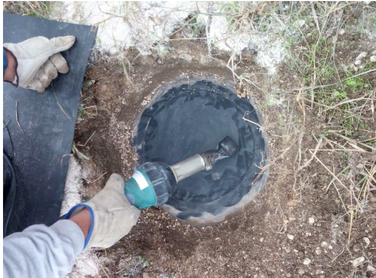
Predisposizione nuova porzione di telo HDPE
