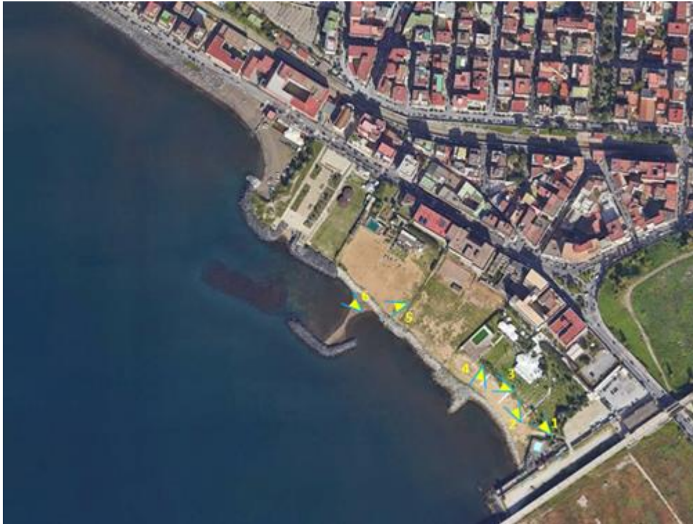
Figura 2-3: Stato attuale dell'Arenile Nord
