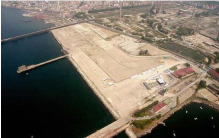
Figura 2-4: Panoramica area di colmata
