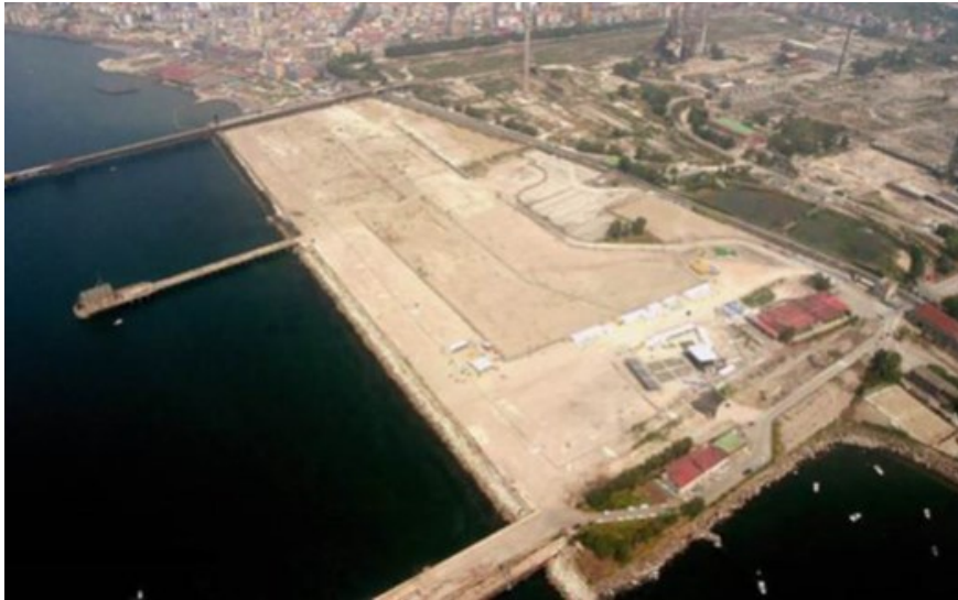
Figura 3-4: Panoramica area di colmata
