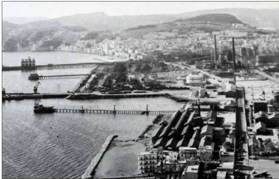
Figura 2.8: La colmata in fase di realizzazione
