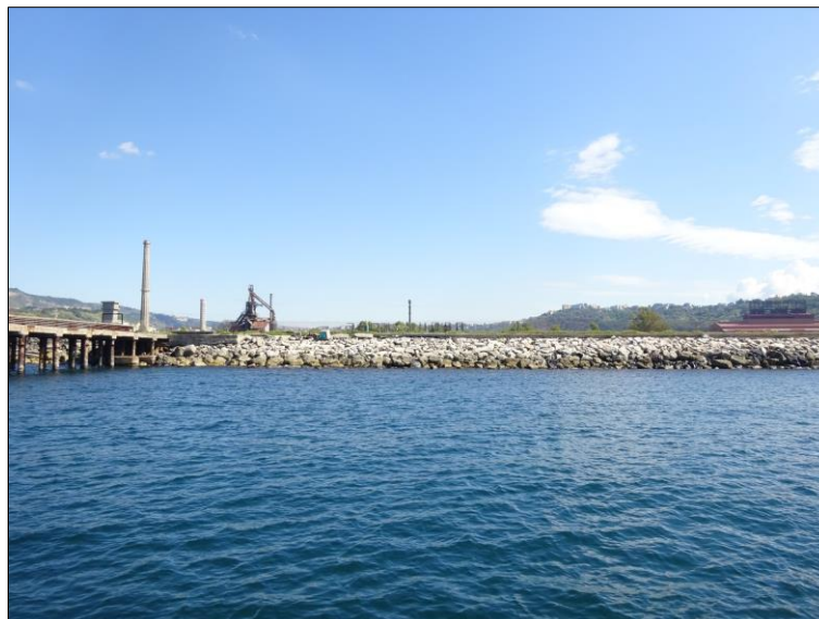
Figura 2.4: Particolare della scogliera frangiflutti che chiude la colmata verso mare
