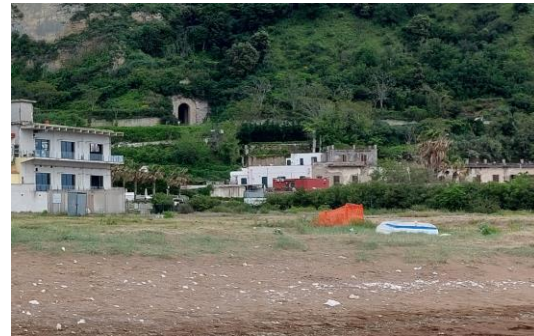
Segnalazione dei piezometri realizzati nell'Arenile Sud
