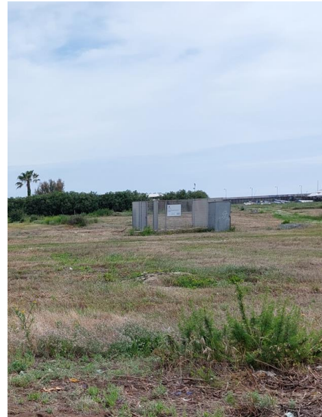
Stazione di sollevamento nell'Arenile Sud
