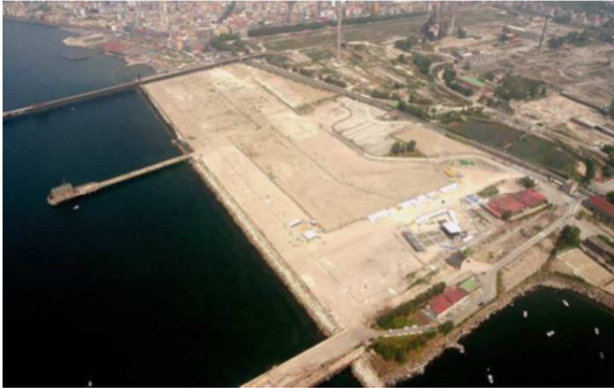
Figura 3.1: Panoramica area di colmata
