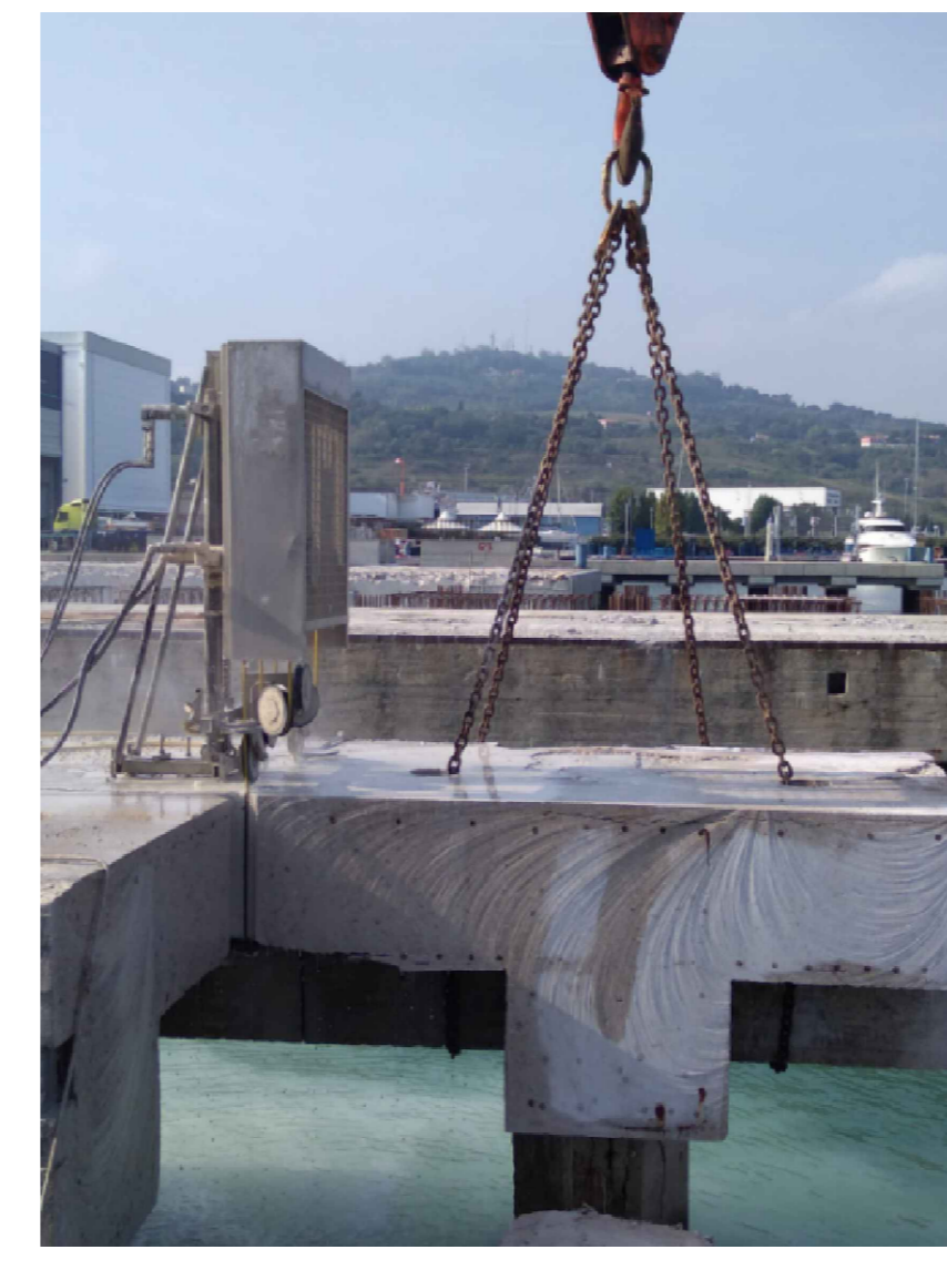
Esempio di sezionamento impalcato mediante taglio a disco e successivo sollevamento.
