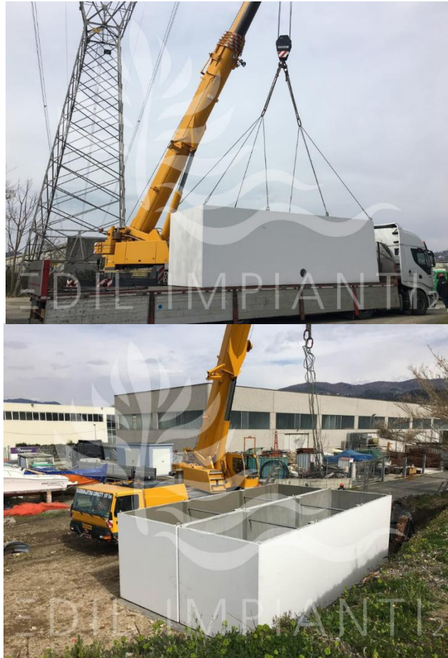
Figura 5 Modello di disoleatore tipo
