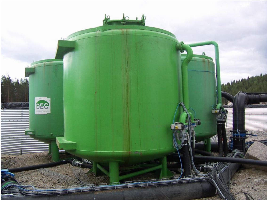
Figura 6 Filtri a sabbia in pressione
