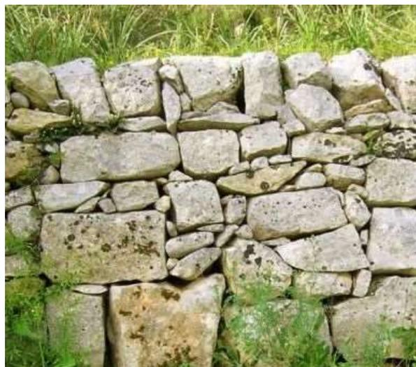
Figura 23 - Tipologie di muri di sostegno: a sx. in cls. con rivestimento in pietrame, a dx. muro a secco
