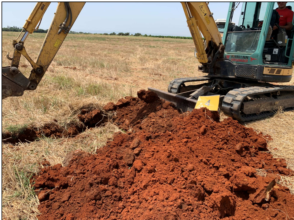
Scavo a pozzo in corrispondenza della Torre 4
