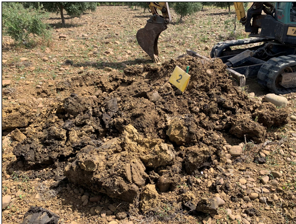
Scavo a pozzo in corrispondenza della Torre 2
