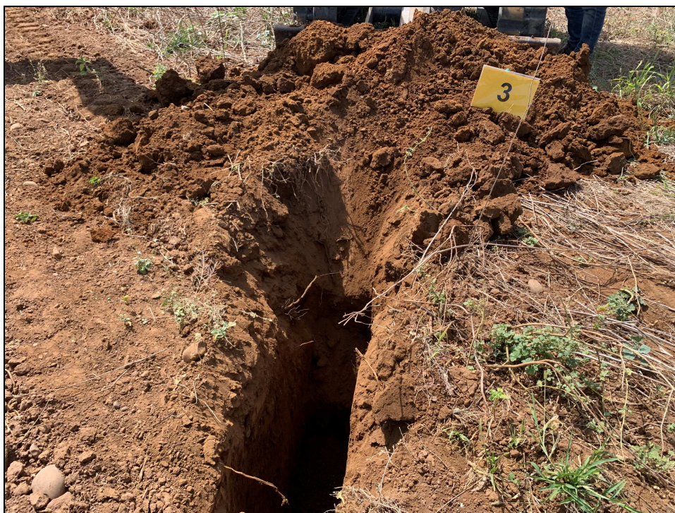
Scavo a pozzo in corrispondenza della Torre 3
