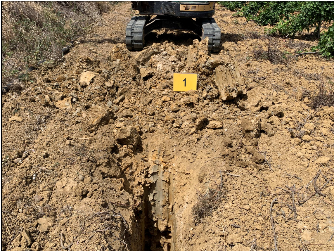
Scavo a pozzo in corrispondenza della Torre 1
