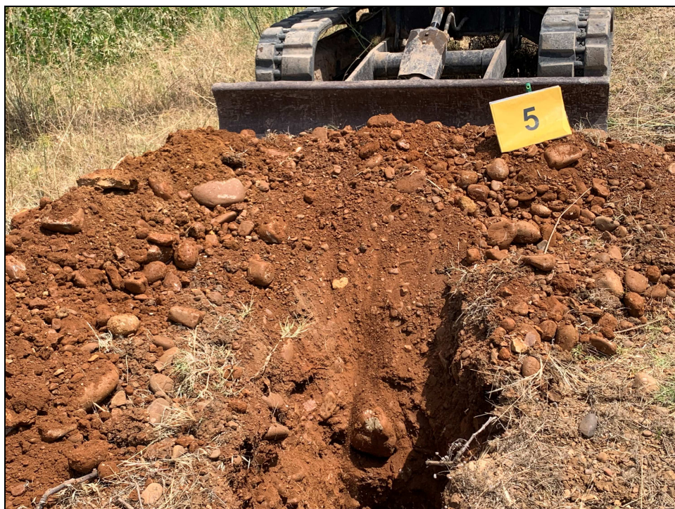
Scavo a pozzo in corrispondenza della Torre 5
