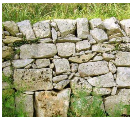
Figura 14 Tipologie di muri di sostegno: da sinistra muro in calcestruzzo con rivestimento in pietrame e muro a secco
