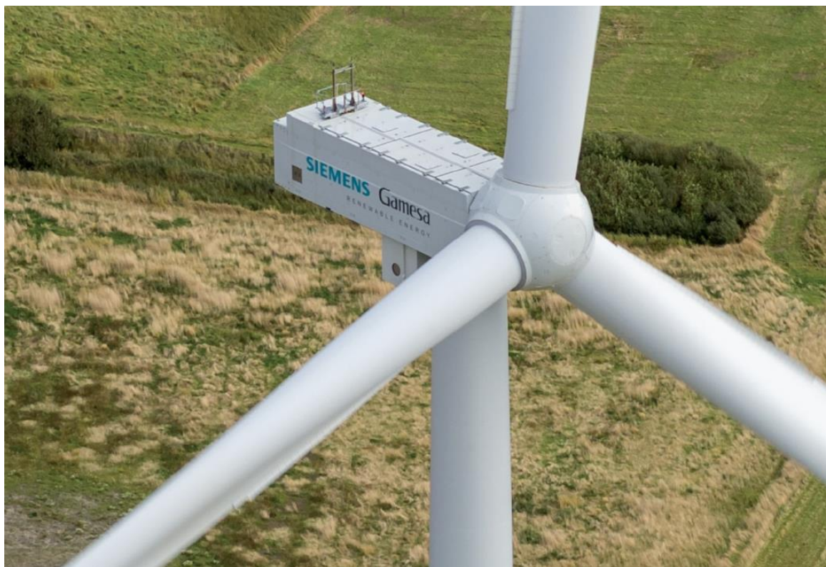
Figura 4 Vista del rotore della turbina tipo Siemens Gamesa SG 170
