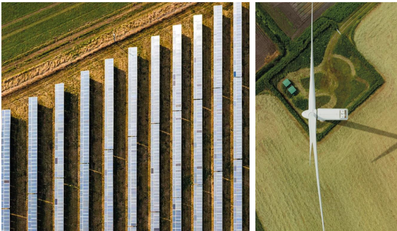
Figura 27 Impianto eolico e fotovoltaico a terra, fonte: GSE Rapporto Statistico 2021
