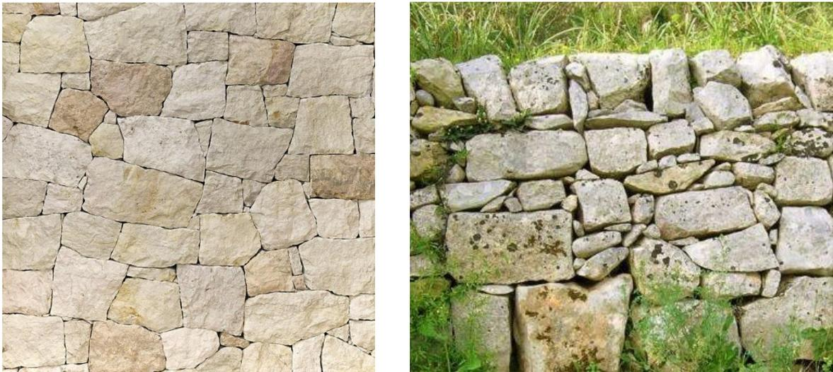
Figura 14 - Tipologie di muri di sostegno: a sx. in cls. con rivestimento in pietrame, a dx. muro a secco
