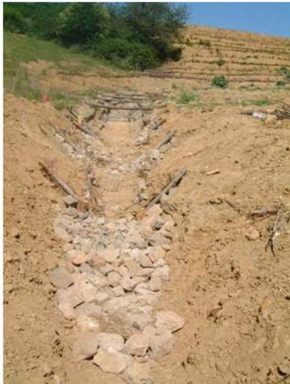
Fig. 02: Sistemazione Impluvio con briglie in legno e pietrame
