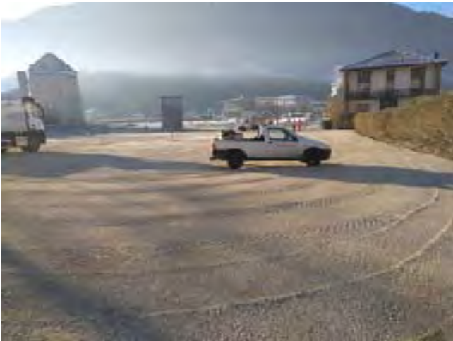
Foto 3 - in materiale drenante
