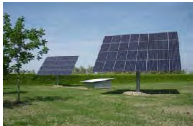
Foto 9 - Impianto fotovoltaico con pannelli ad inseguimento
