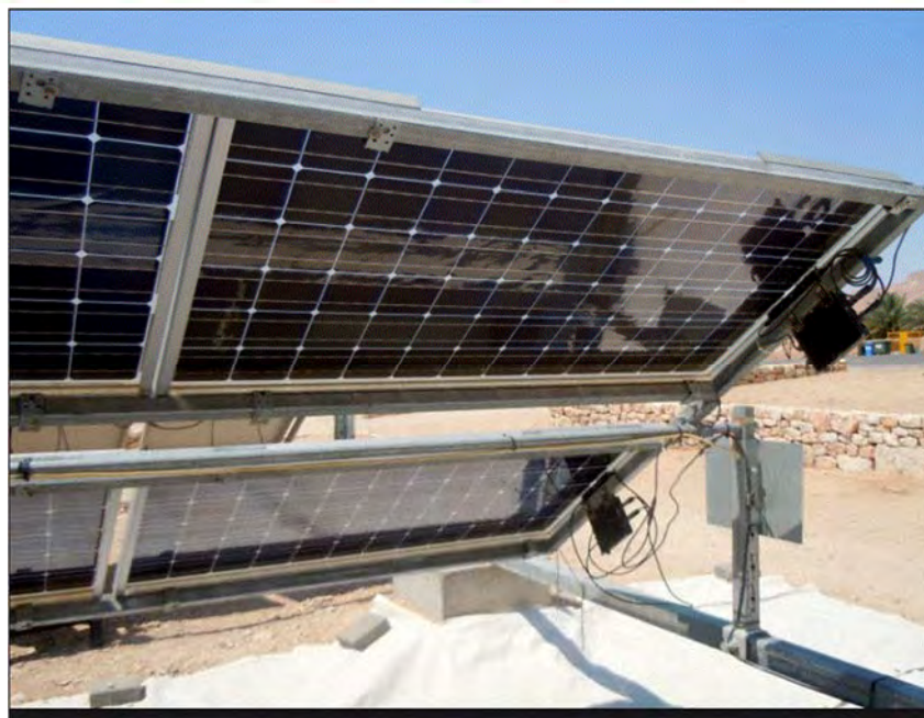
Figura 42 - Tipico Modulo agrovoltaico Bifacciale
