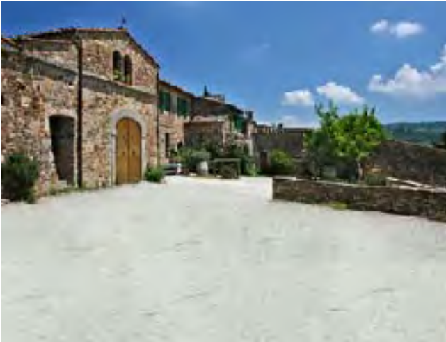
Foto 5 - in materiale stabilizzato
