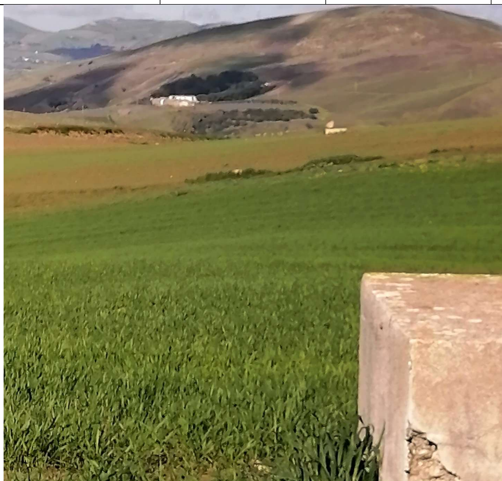
Tratto del cavidotto su strada inesistente verso aerogeneratore A02
