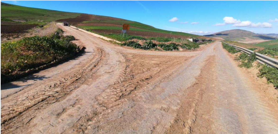
Cavidotto su SP 107 e innesto cavidotto su Strada Consortile di Carbone (verso Aerogeneratori A02, A03, A04 e A05).
