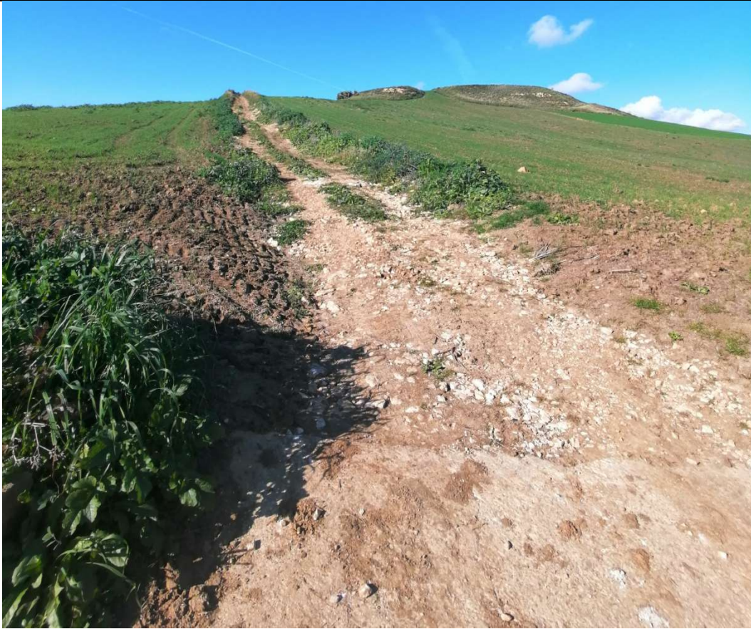
Cavidotto interno verso Aerogeneratore A03 che ricalca strada interpoderale
