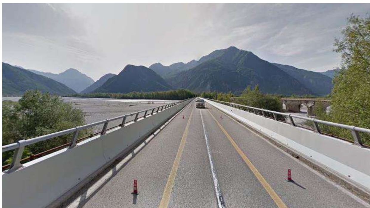
Figura 7.12 – Vista n.2 Presa dal ponte oggetto di intervento in direzione del comune di Venzone
