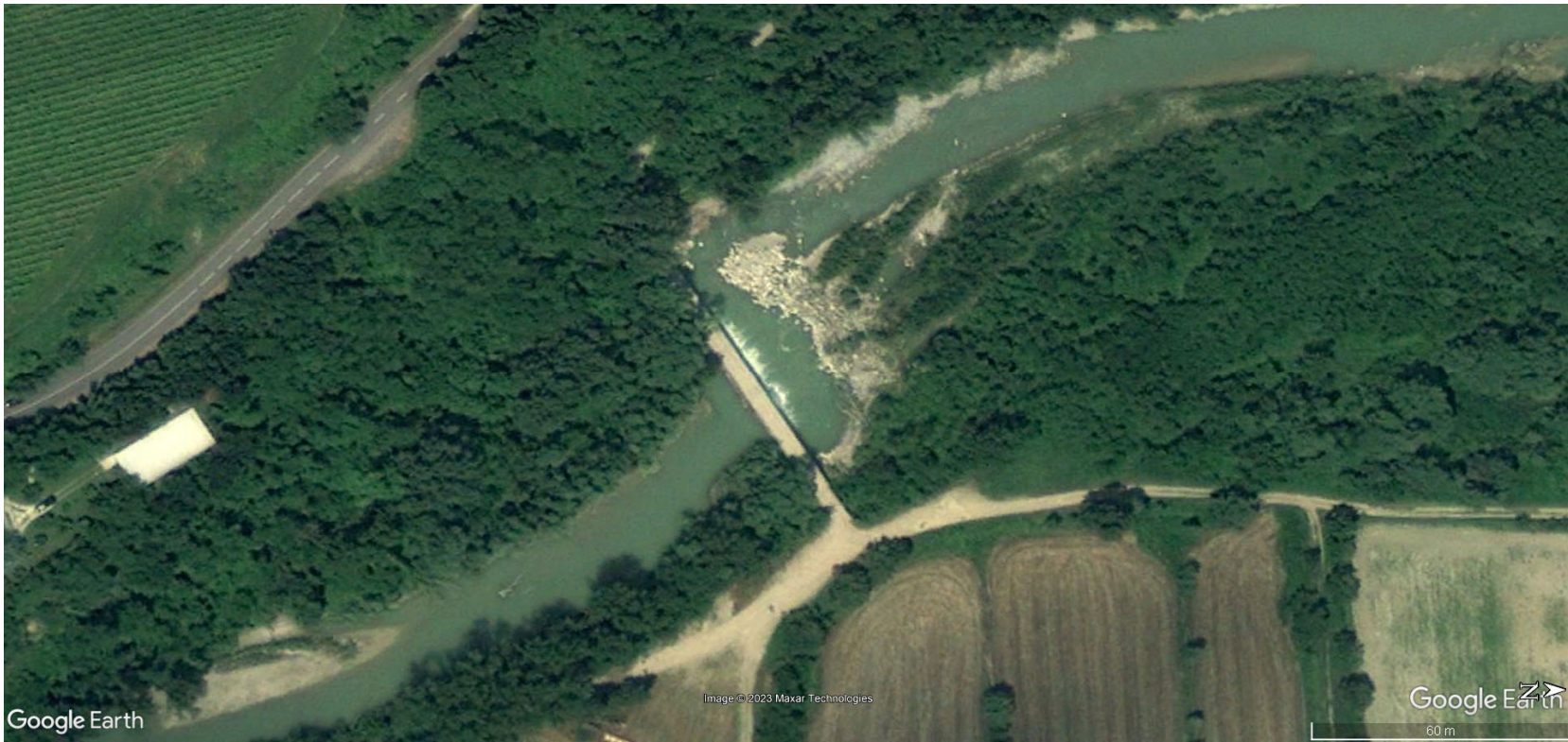
Fig. 2.4/A: Passerella sul F. Savio in località Piaia immagine area del giugno 2010
