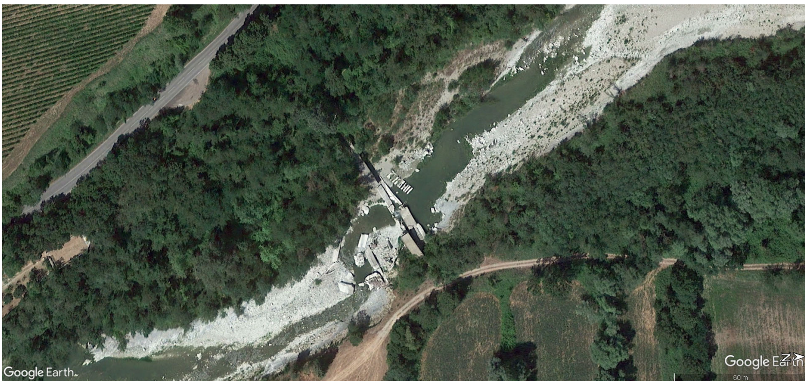
Fig. 2.4/B: Passerella sul F. Savio in località Piaia - immagine area del luglio 2021
