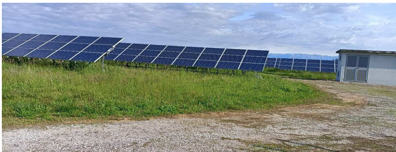
Foto 1 – Vista dell'impianto esistente
