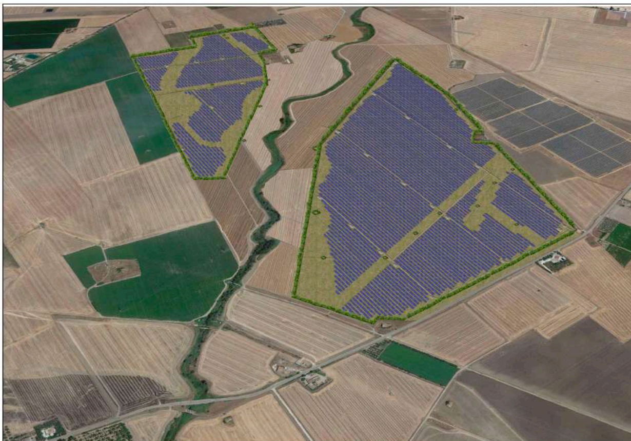
Figura 2.59 VISTA DA DRONE - Impianto in progetto - sulla destra l'impianto già realizzato
