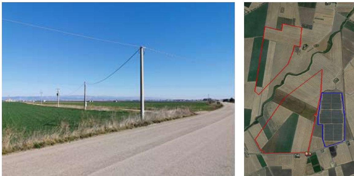
Figura 2.55: Vista 1 dall'impianto in progetto verso impianto più prossimo – Stato di fatto
