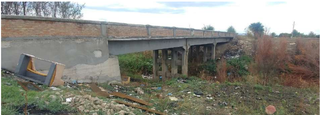
Figura 4.23: punto di attraversamento della connessione elettrica in corrispondenza del torrente Celone
