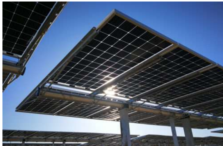
Figura 2.41: Esempio di struttura tipo tracker monoassiale
