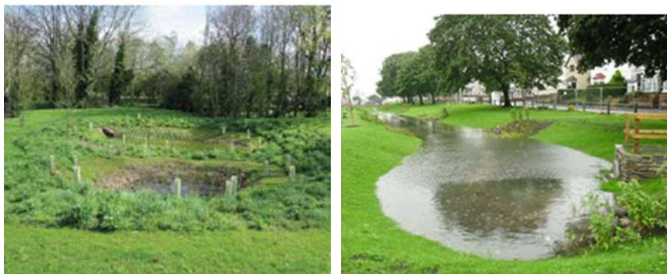
Figura 4.111: Immagini esemplificative di bacini di infiltrazione
