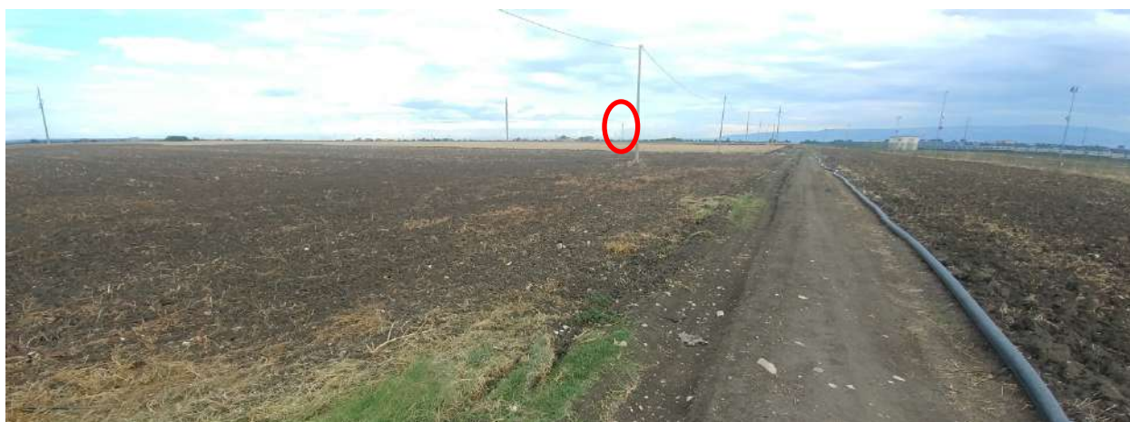
Figura 2.66: Identificazione dell'aereogeneratore posto a nord dell'impianto in progetto – Fotografia del 4/10/2019
