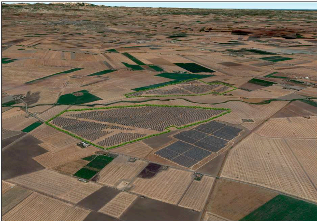
Figura 2.60 VISTA DA DRONE - Impianto in progetto - sulla destra l'impianto già realizzato
