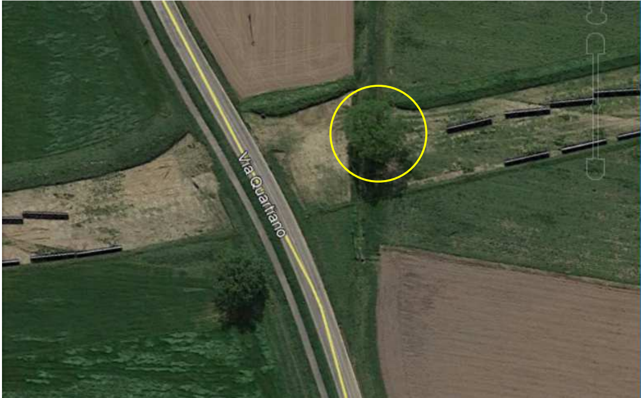
Fig. 2.2 - orto foto della fascia di cantiere e posizione della farnia mantenuta nella fase preliminare del cantiere
