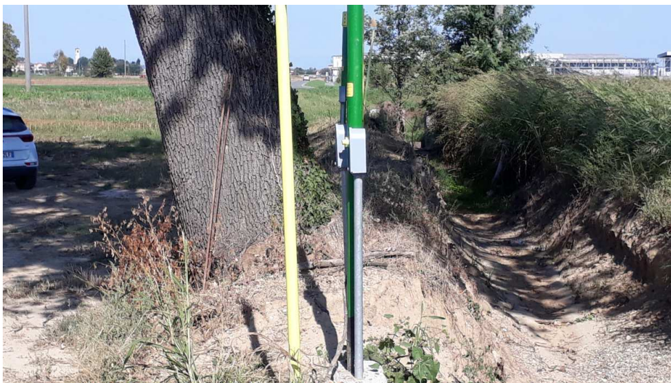
Fig. 2.8 - particolare della zona del colletto in prossimità del fosso e del passaggio della condotta in sotterraneo
