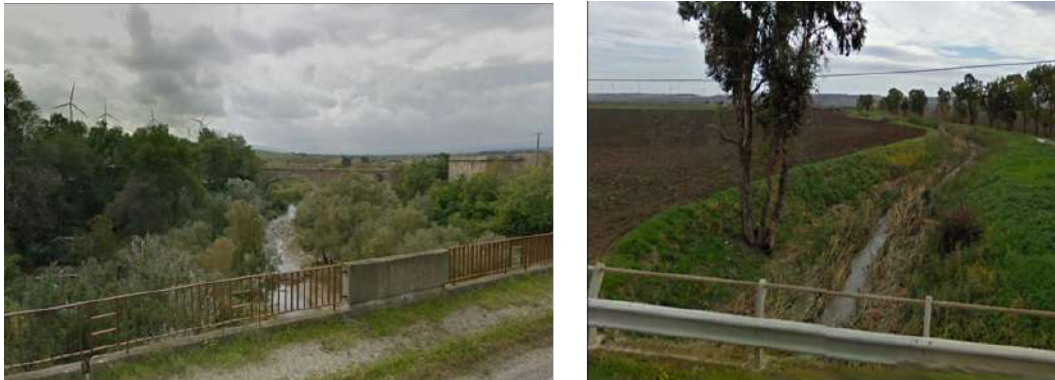
Figura 4.46: Foto da rilievo- da sinistra verso destra- Torrente Carapelle a monte dell'area di progetto e Torrente Carapellotto post attraversamento SS655.
