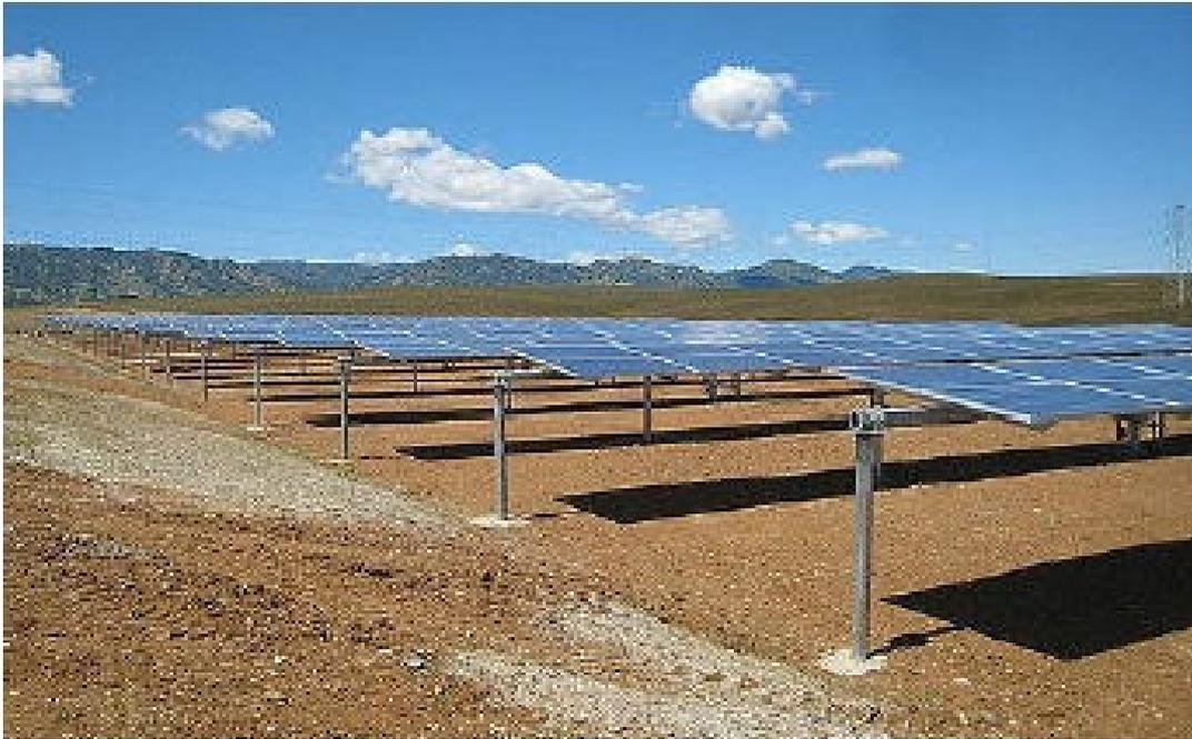
La messa in opera di tale sistema richiede l'installazione nel terreno di profilati in acciaio ad una profondità di circa 2 metri, effettuando piccoli scavi e ridotte quantità di movimenti terra. Inoltre ottenendo un incremento della produzione di energia rispetto alle strutture fisse, questa tecnologia consente l'utilizzo di una superficie di installazione minore a parità di potenza installata.
