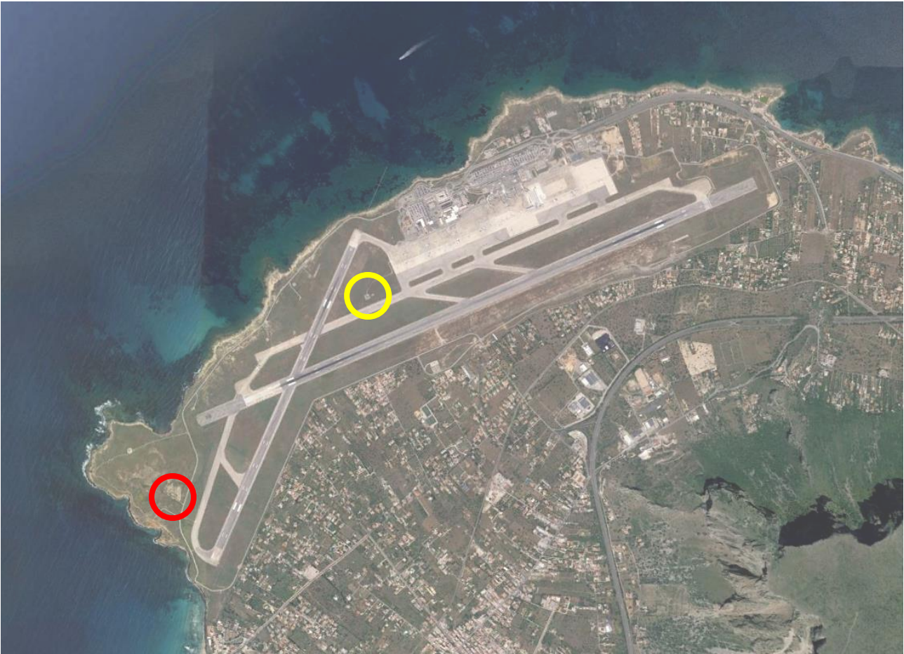
Fig. 1 – Foto aerea del sito dell'Aeroporto di Palermo Punta Raisi (PA) con individuazione delle aree di intervento: in rosso il sito del nuovo Radar, in giallo il sito del Radar esistente.
