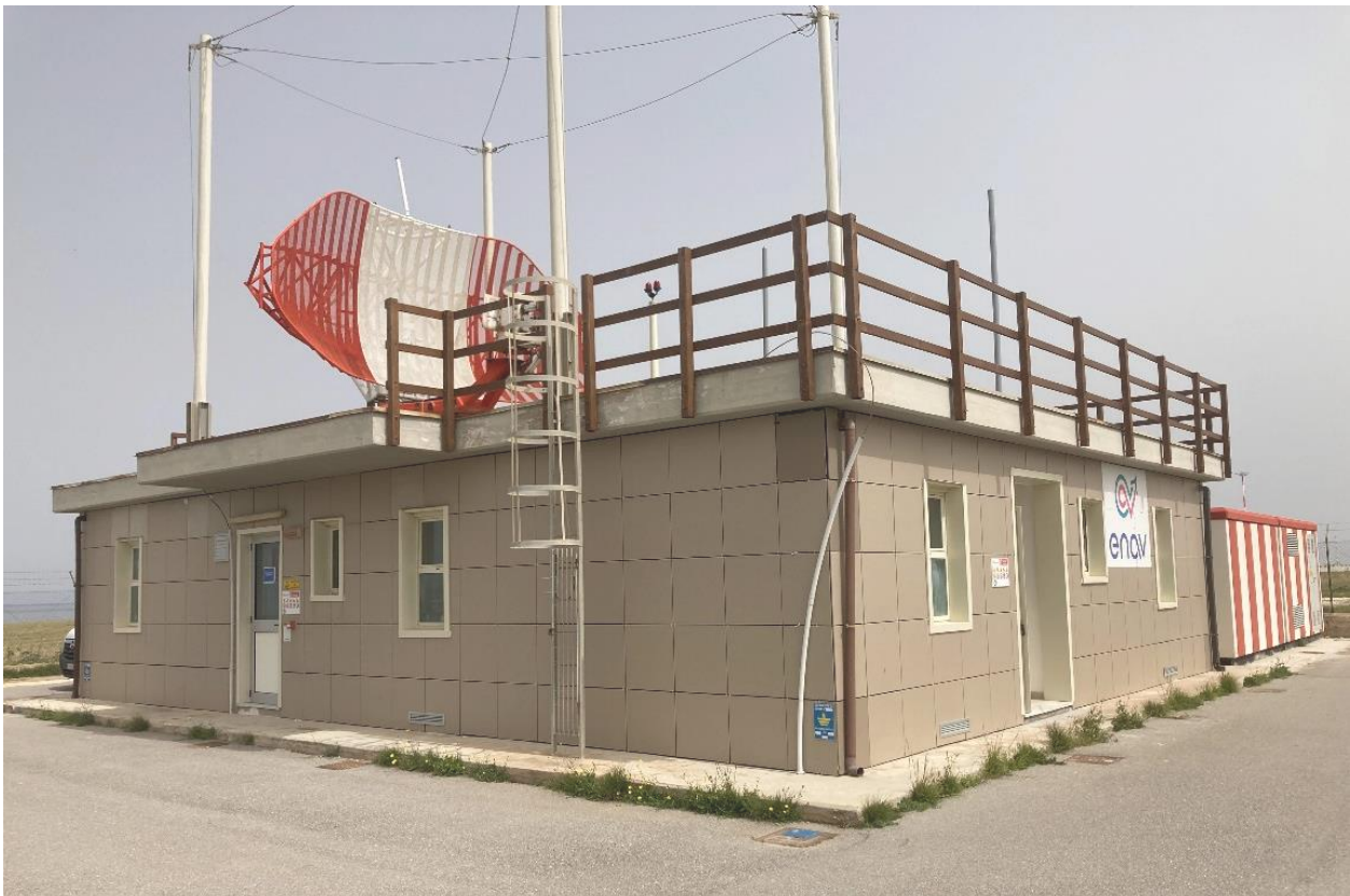
Fig. 8 – Vista dell'attuale fabbricato Radar da demolire.
