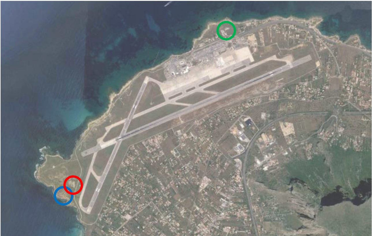
Fig. 26 – Foto aerea del sito dell'Aeroporto di Palermo Punta Raisi (PA) con individuazione delle tre possibili ubicazioni del nuovo Radar.
