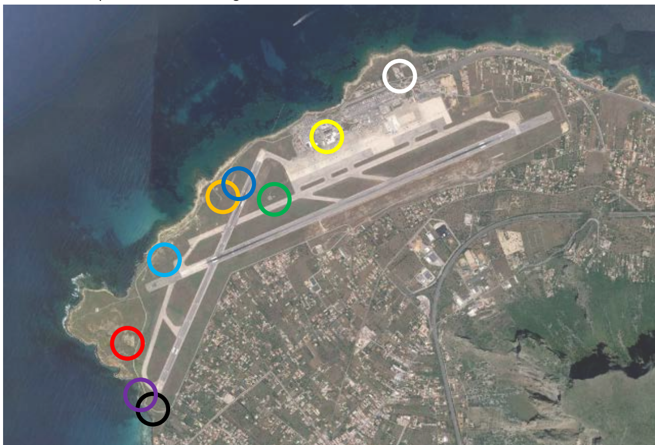
Fig. 2 – Foto aerea del sito dell'Aeroporto di Palermo Punta Raisi (PA) con individuazione delle aree di intervento.
