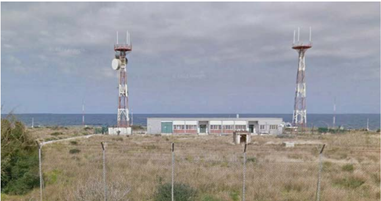
Fig. 42 – Vista del C.R.T. aeroportuale con i due tralicci attualmente esistenti.
