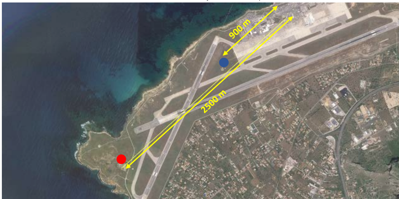
Fig. 39 – Foto aerea del sito del nuovo Radar (in rosso) e del sito del Radar esistente (in blu) con evidenziazione della distanza dei due siti dal fabbricato dell'aerostazione.
