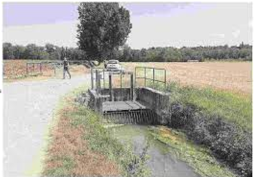
La condotta irrigua Tavernago-Tesa che sarà coperta e resa impermeabile (07/08/2019)
