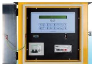
Gestione e segnalazione delle anomalie, delle pause e delle interruzioni di rete. Tali eventi vengono registrati nella memoria e possono essere segnalati tramite SMS con il modem installato (scheda SIM non in dotazione)
