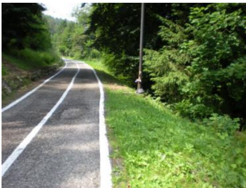
Foto 2-5 - Particolare dell'area di rilievo FAU_02 (Giugno 2022)
