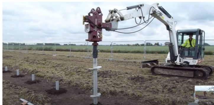
Figura 12-3 Macchina Operatrice per fissaggio supporti strutture
