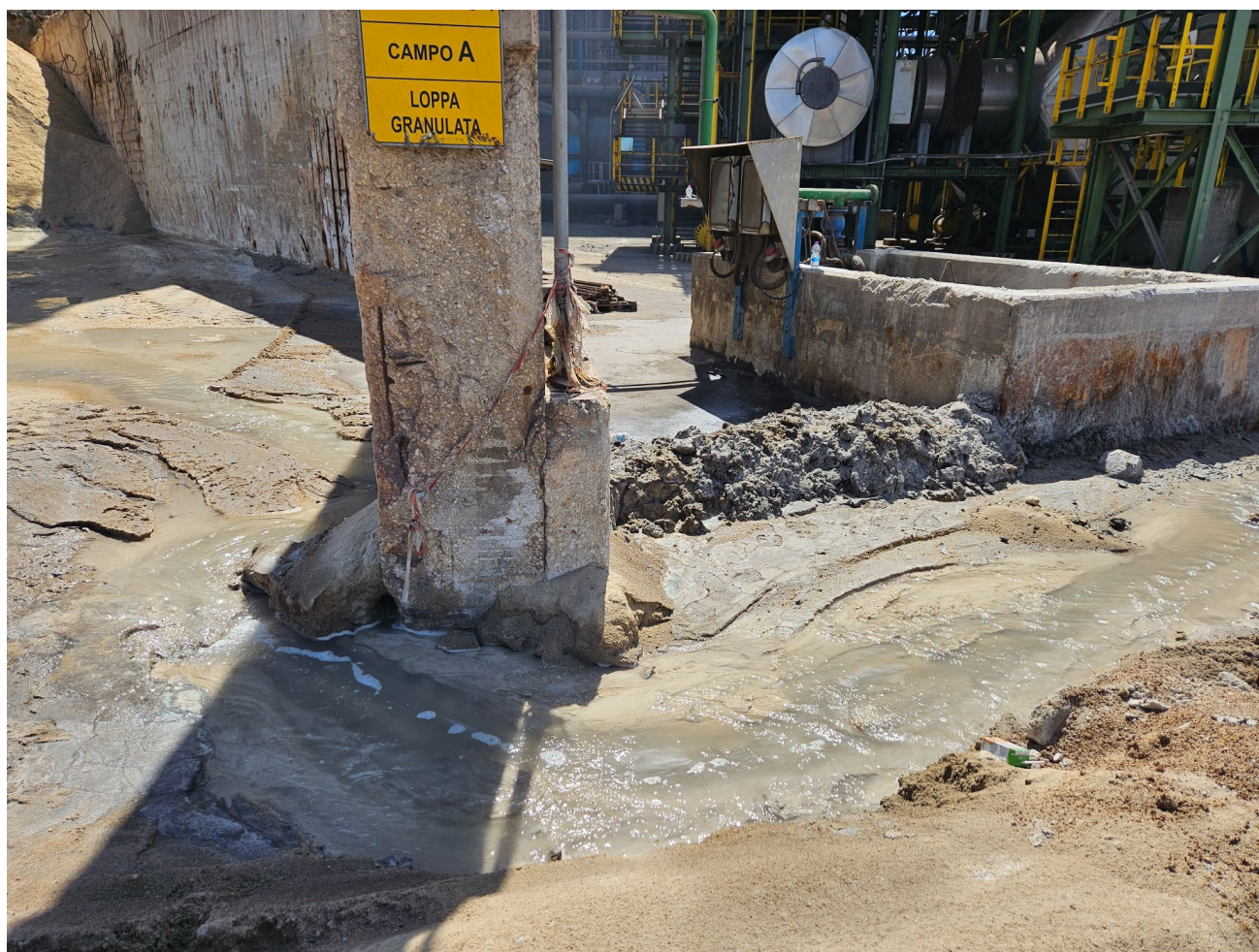
Figura 5. Argine in loppa per per convogliare le acque di drenaggio nel pozzetto trappola. (foto n. 20230830_123447)
