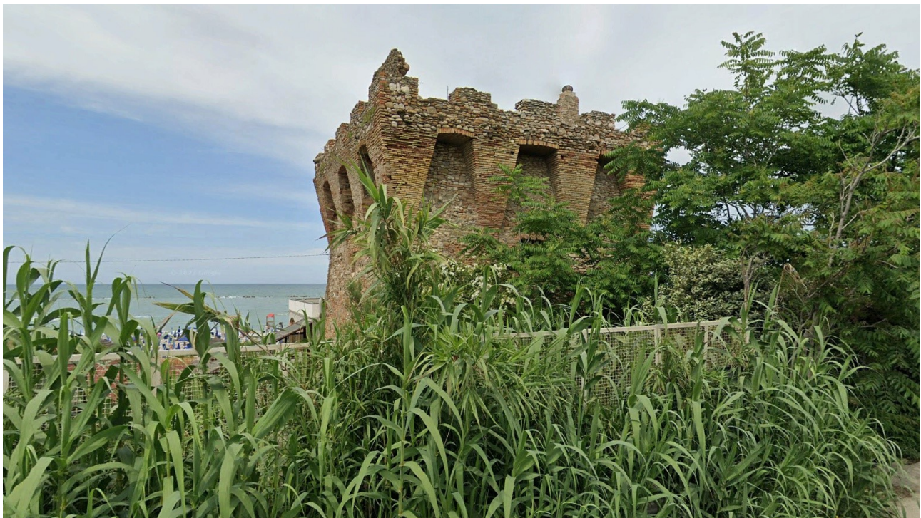
Figura 64 - Torre del Sinarca
