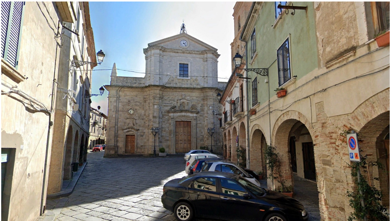
Figura 57 - Vista frontale della Chiesa di Santa Maria Maggiore a Guglionesi
