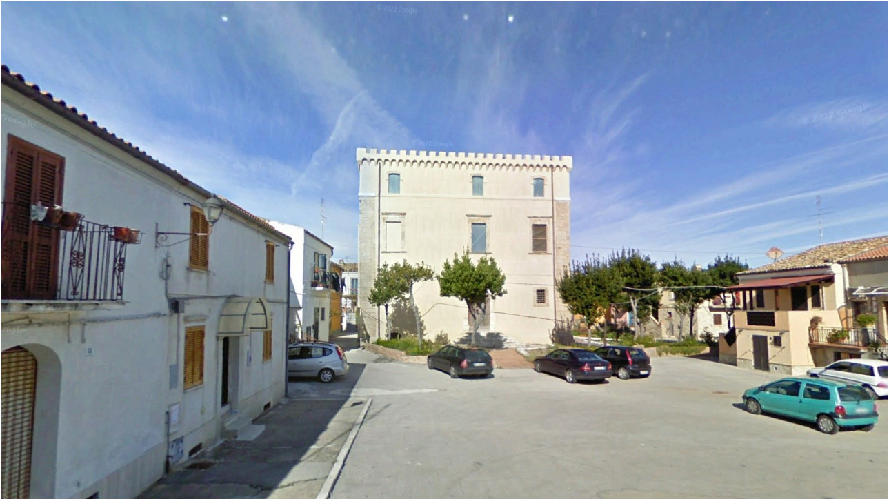
Figura 52 – Vista frontale del Palazzo Ducale Battiloro a Petacciato
