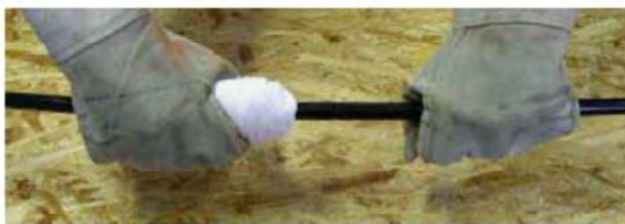
Pulizia della superficie esterna
