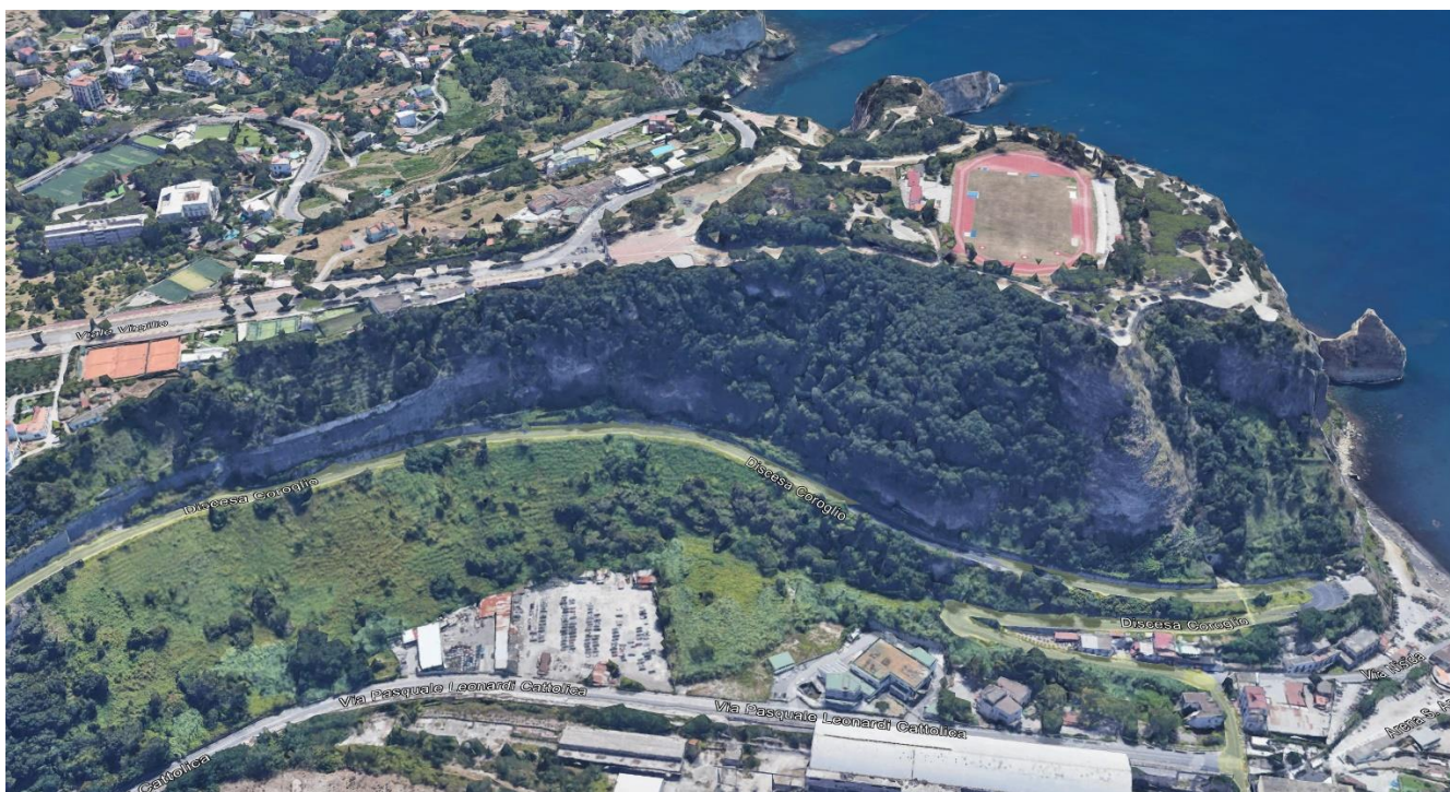
Panoramica dell’area oggetto d’intervento
