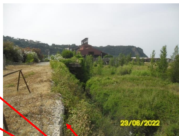
Muro in c.a. in demolizione
