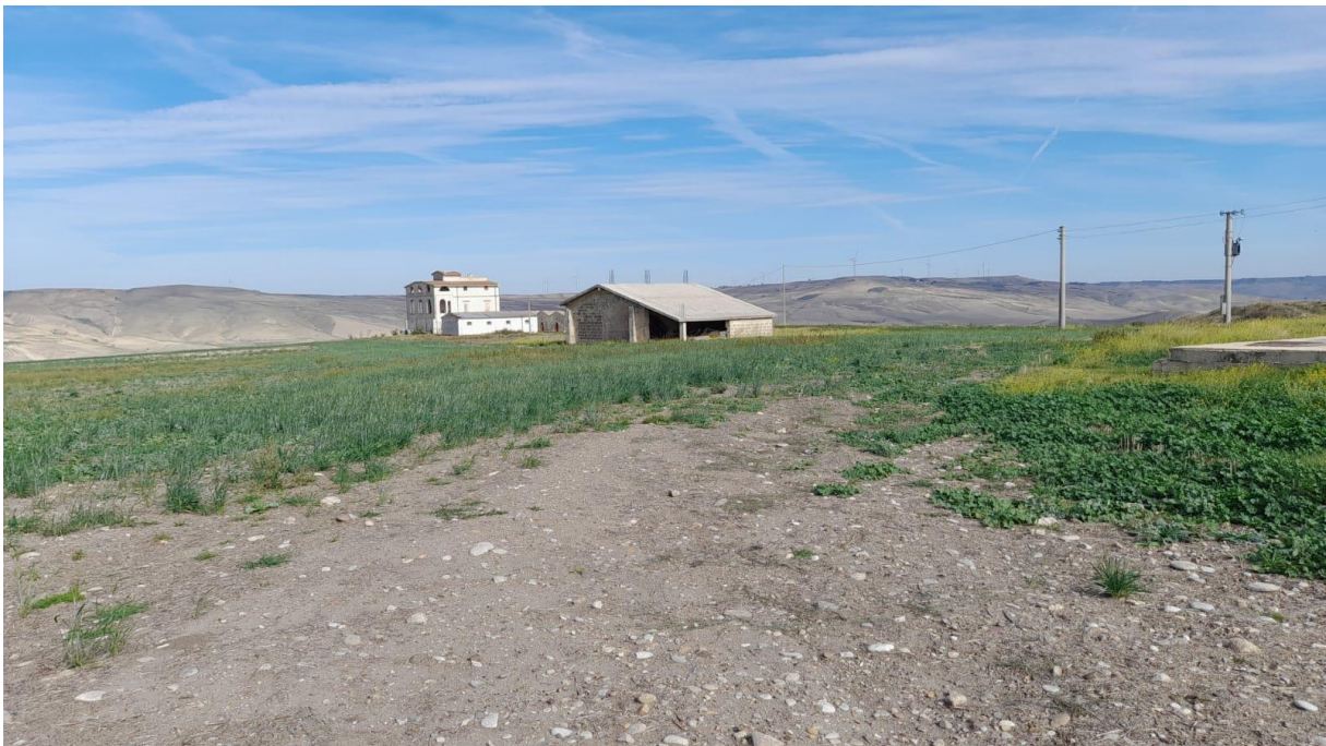
Figura 77 Vista fabbricato n.48, n.49, n.50 e n.51
