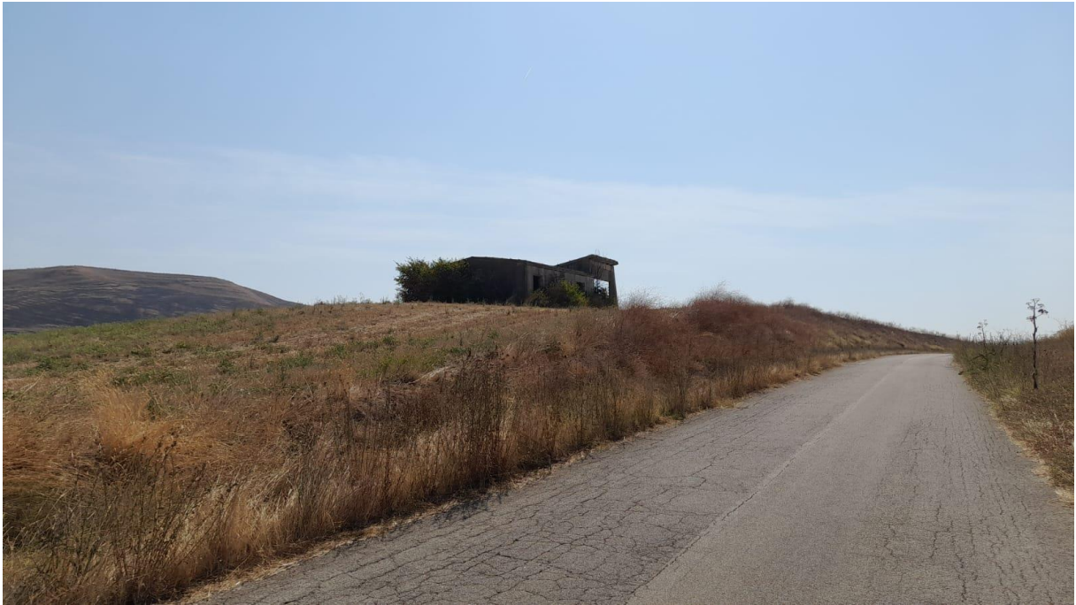
Figura 56 Vista fabbricato n.8
