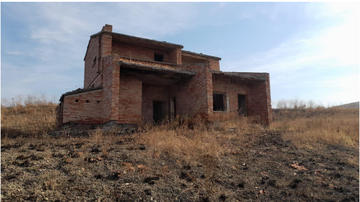
Figura 61 Vista fabbricato n.15
