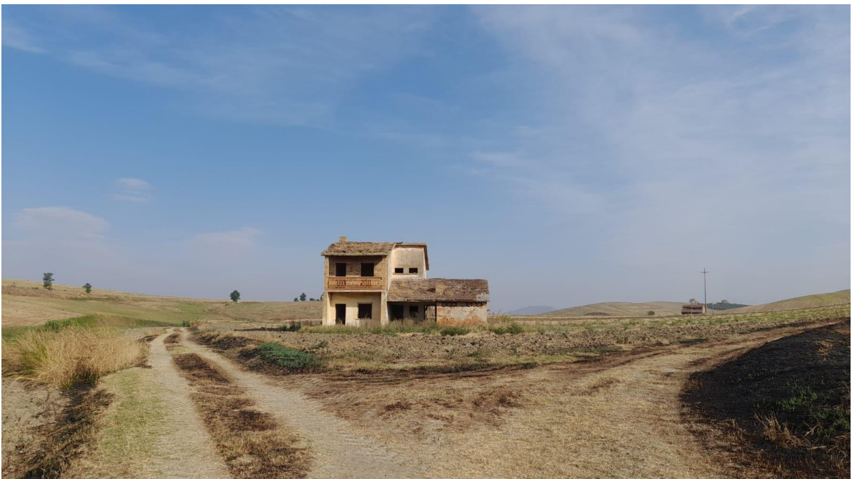
Figura 59 Vista fabbricato n.13
