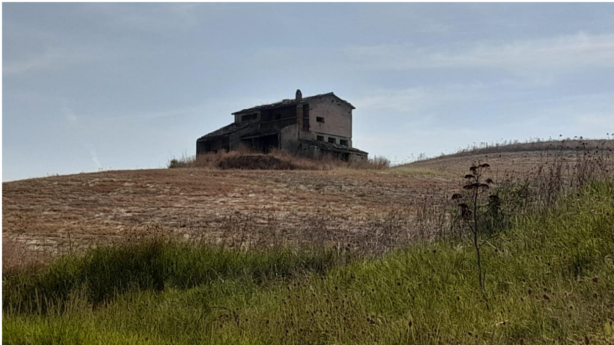
Figura 53 Vista fabbricato n.3
