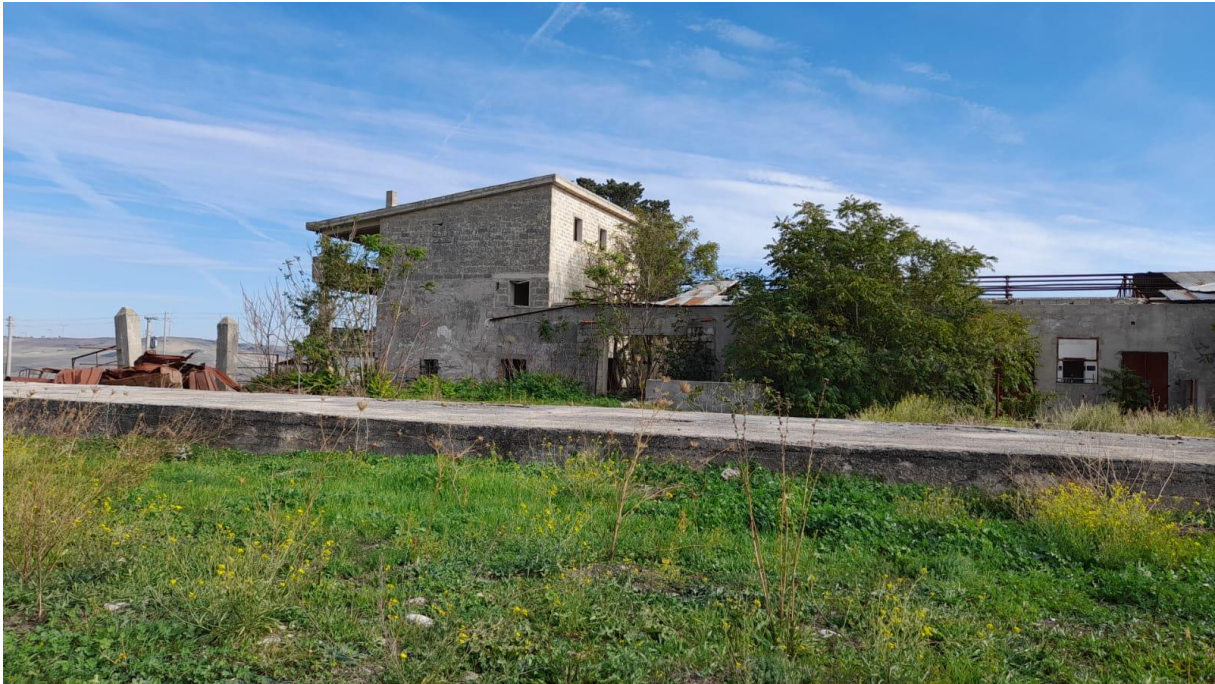
Figura 76 Vista fabbricato n.44, n.45, n.46 e n.47
