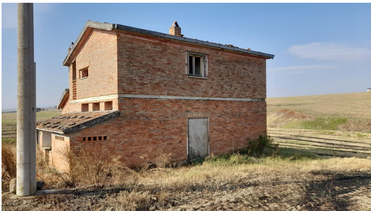
Figura 51 Vista fabbricato n.1
