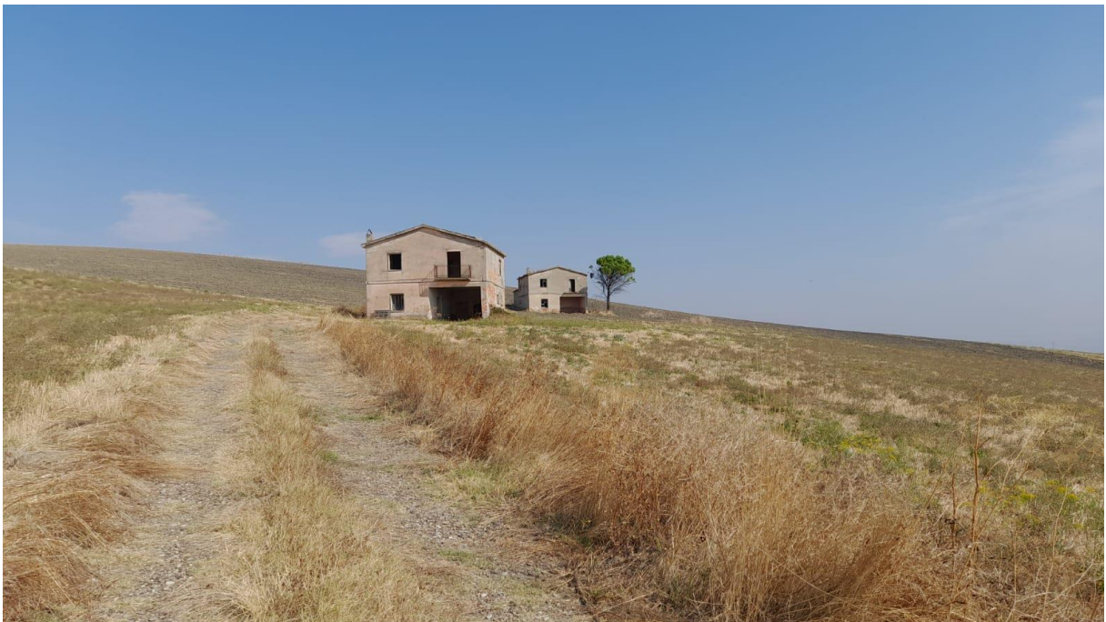
Figura 55 Vista fabbricato n.6 e n. 7
