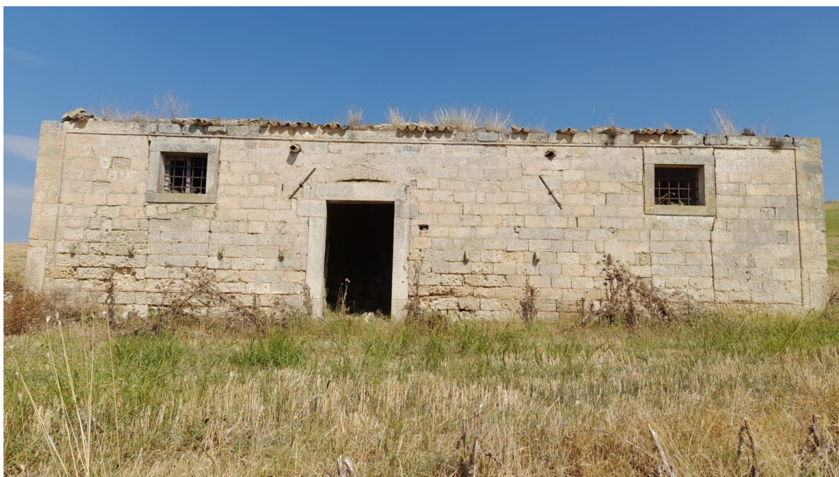
Figura 69 Vista fabbricato n.31
