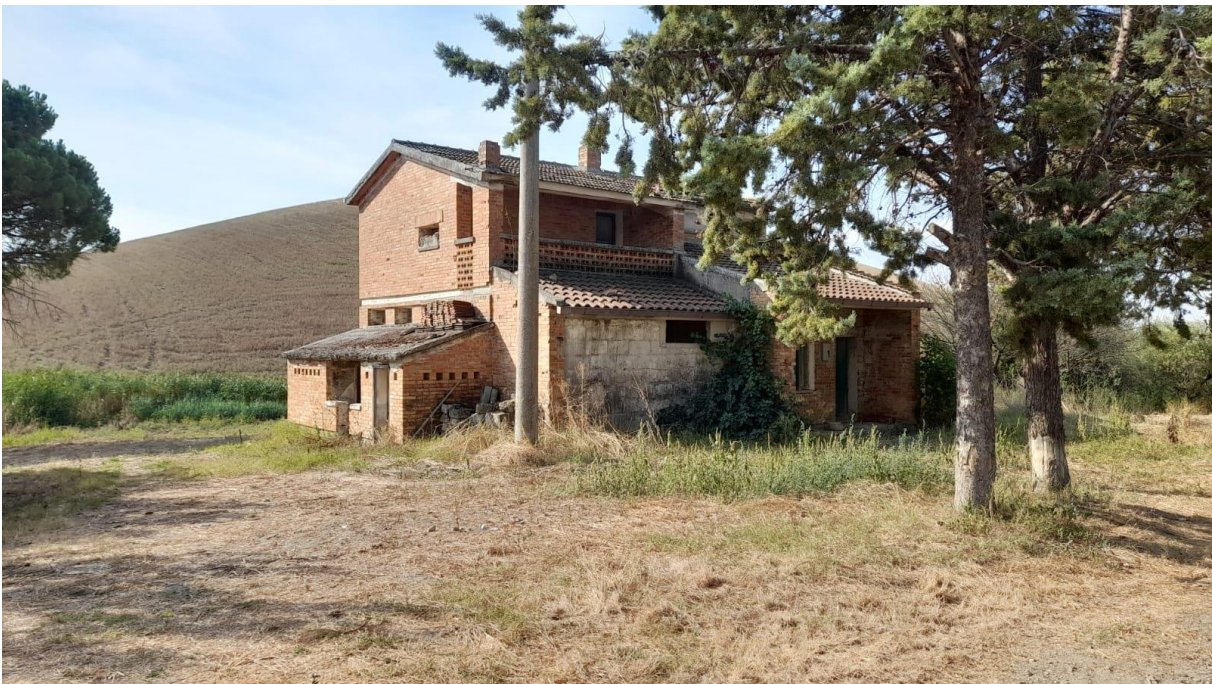
Figura 63 Vista fabbricato n.17
