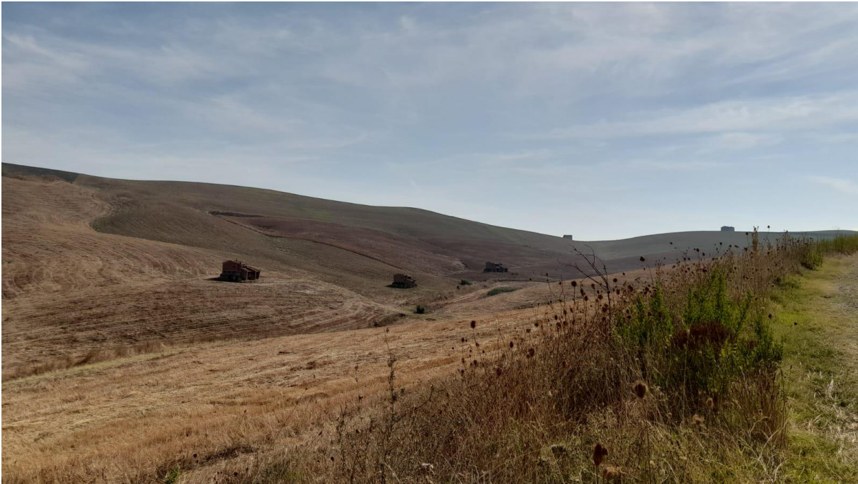
Figura 66 Vista fabbricato n.20, n.21 e n.22
