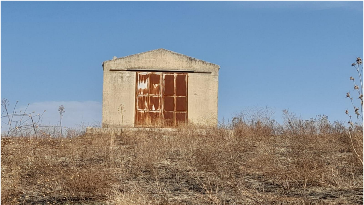
Figura 60 Vista fabbricato n.14
