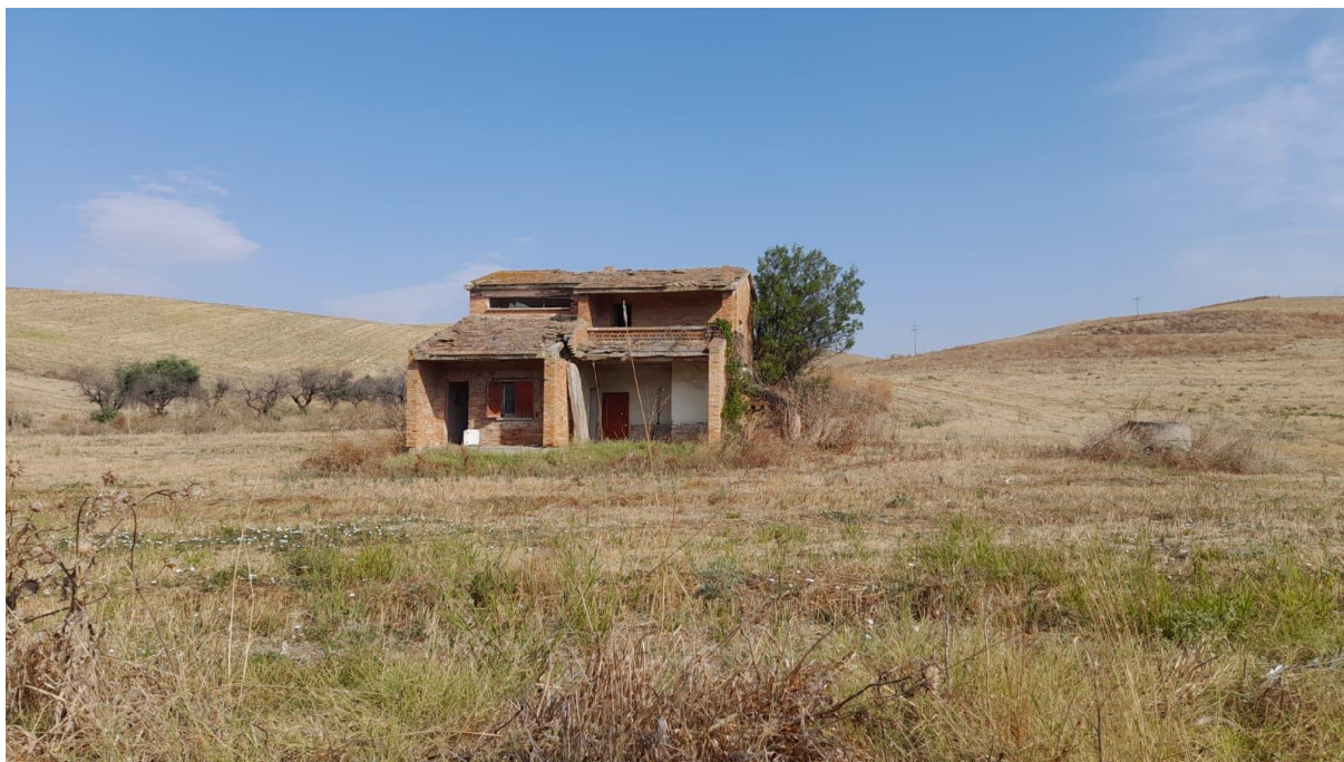
Figura 64 Vista fabbricato n.18
