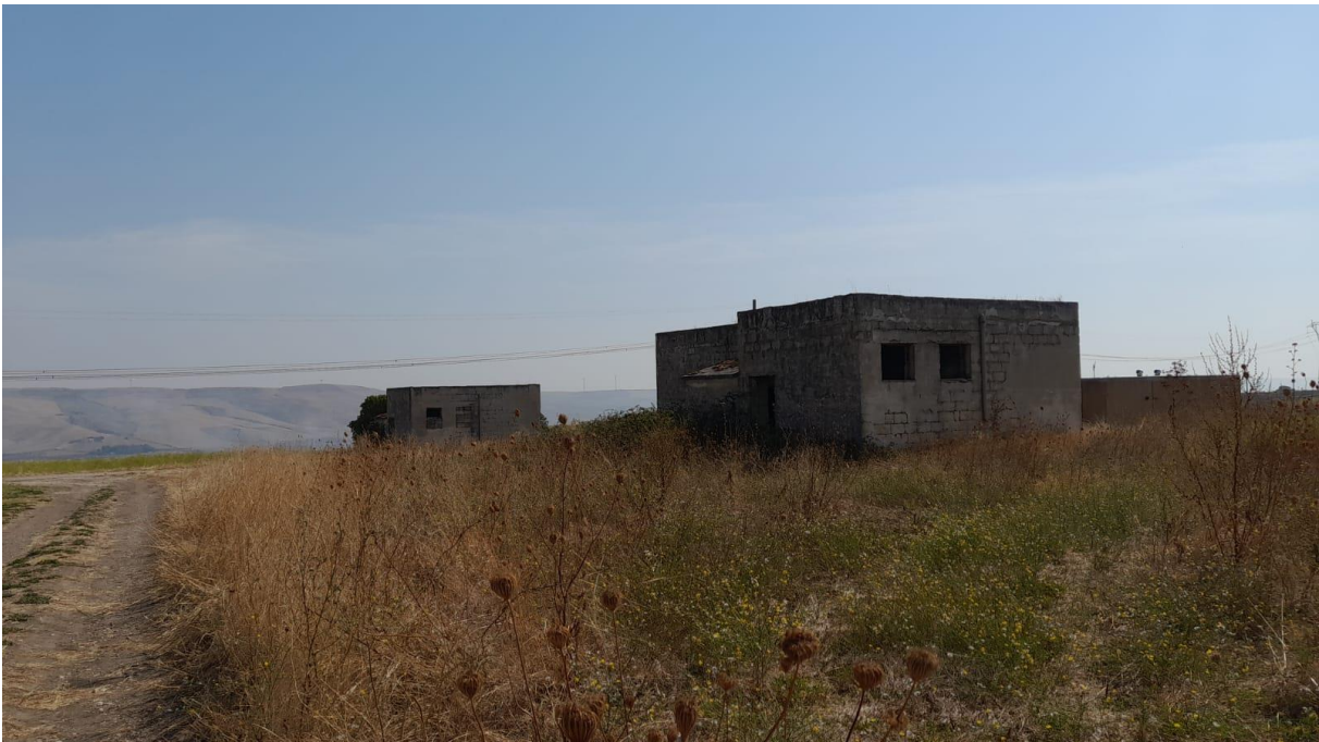
Figura 75 Vista fabbricato n.41 e n.42
