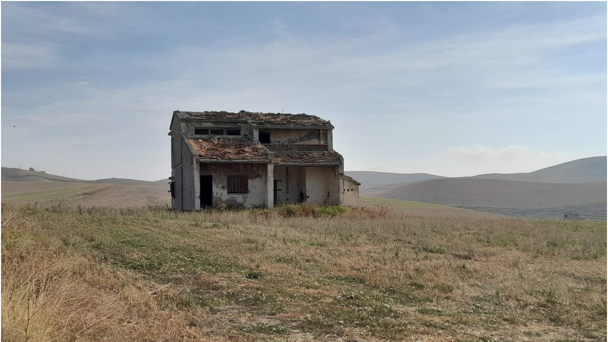
Figura 58 Vista fabbricato n.12
