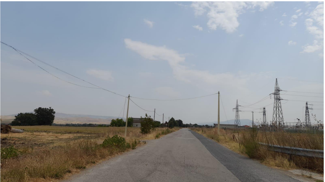
Figura 11 Accesso sottostazione "Terna" in agro di Oppido Lucano
