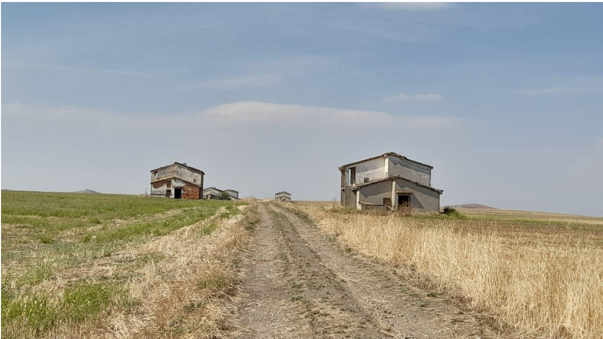
Figura 73 Vista fabbricato n.38 e n.39
