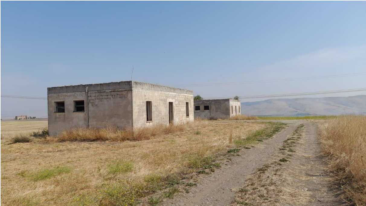
Figura 74 Vista fabbricato n.40 e n.43
