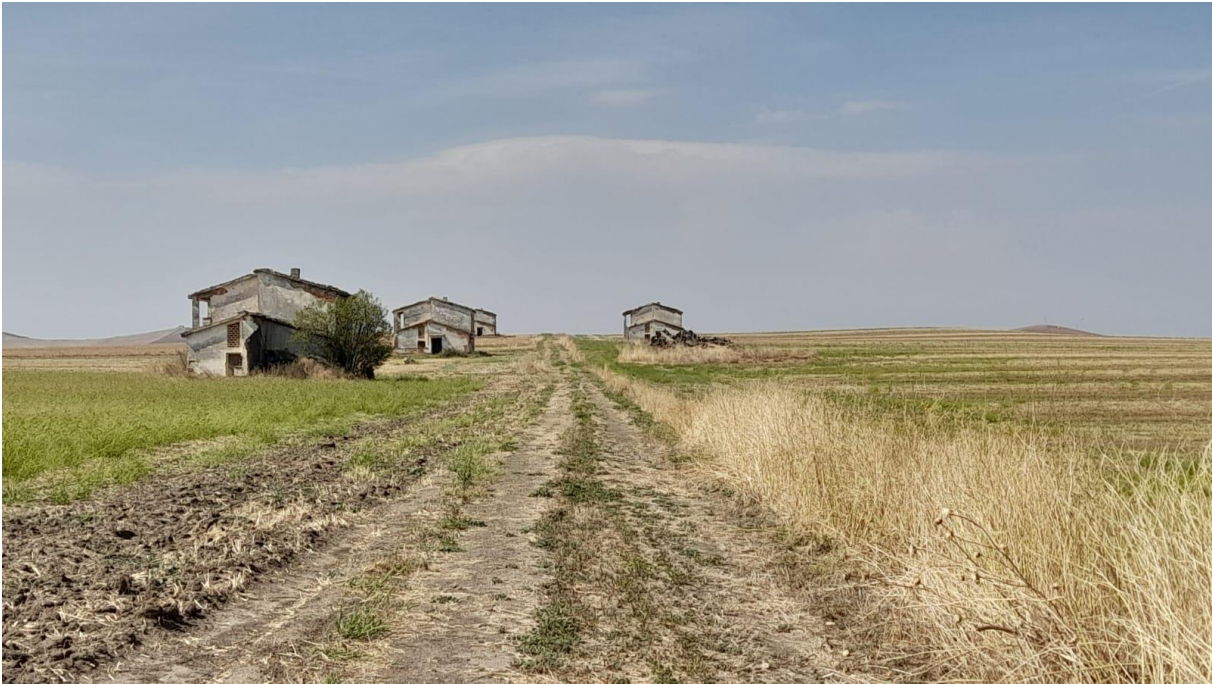
Figura 72 Vista fabbricato n.34, n.35, n.36 e n.37
