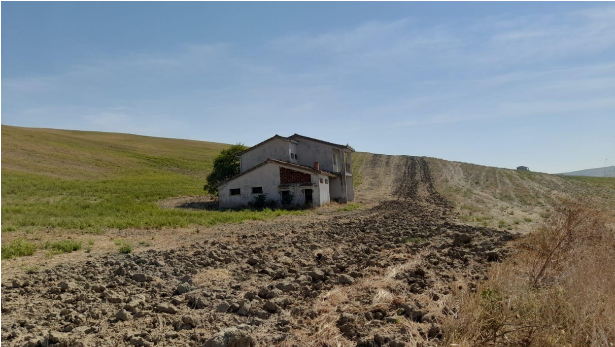
Figura 70 Vista fabbricato n.32
