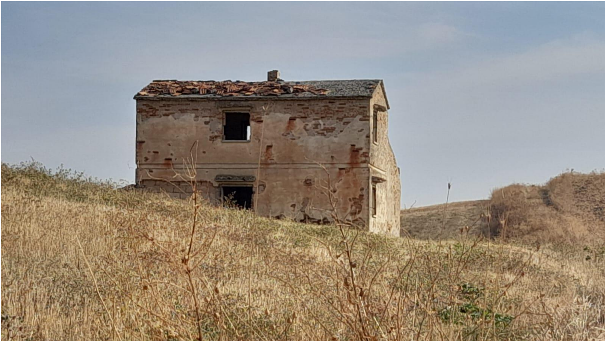
Figura 62 Vista fabbricato n.16
