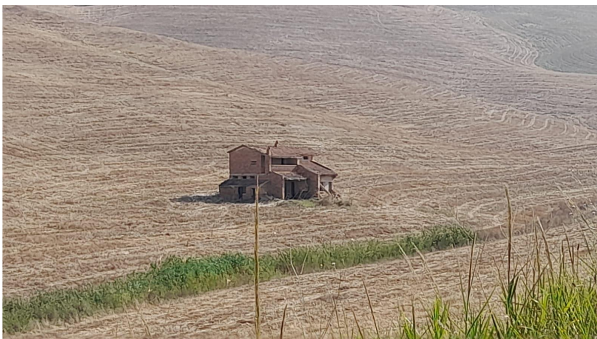
Figura 65 Vista fabbricato n.19
