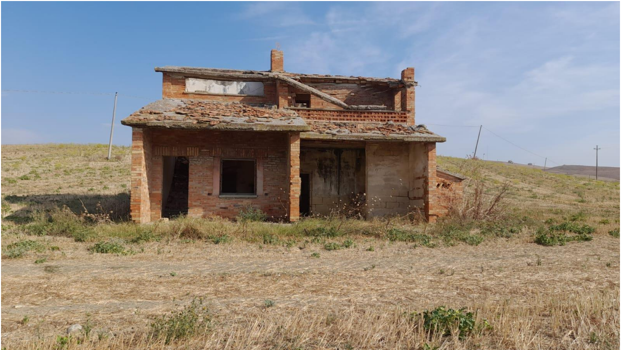
Figura 52 Vista fabbricato n.2
