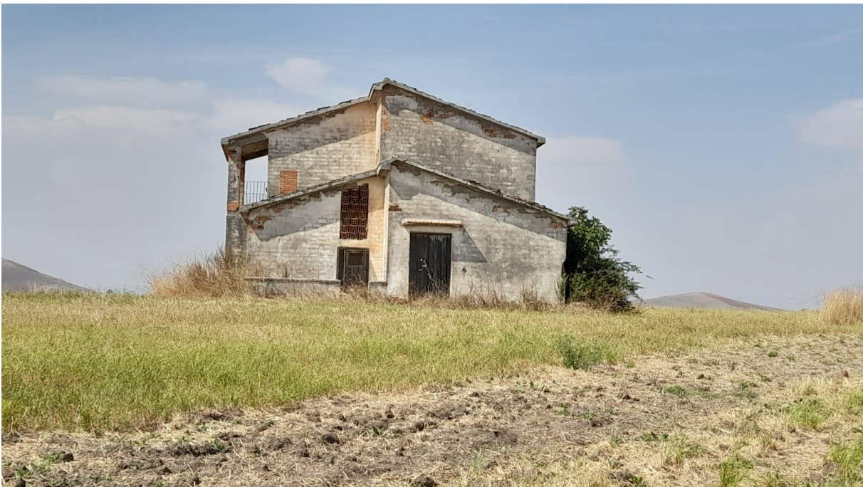
Figura 71 Vista fabbricato n.33
