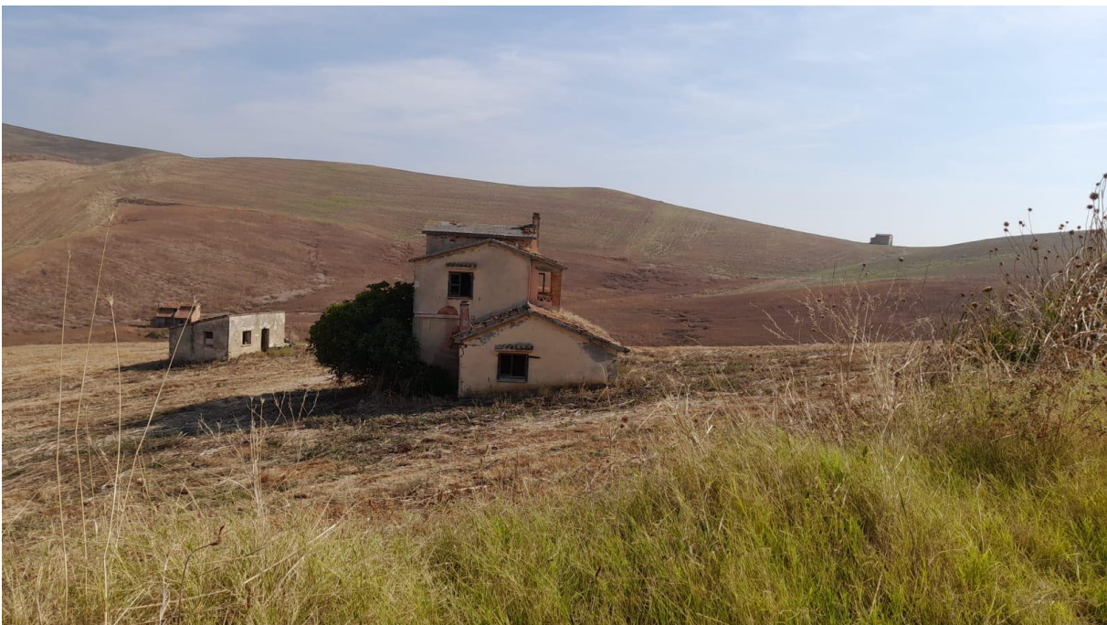
Figura 67 Vista fabbricato n.23
