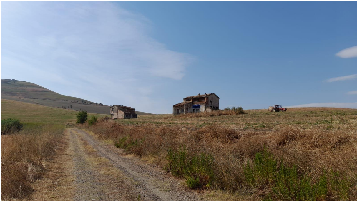
Figura 54 Vista fabbricato n.4 e n. 5
