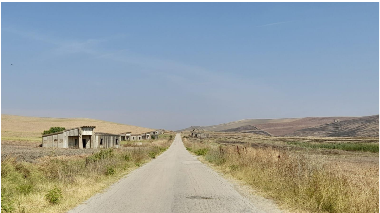
Figura 57 Vista fabbricato n.9, n.10, n.11, n.24, n.25, n.26, n.27 e n. 28
