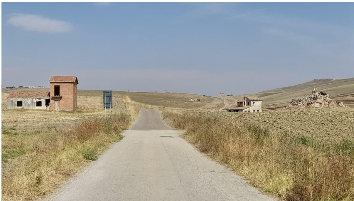
Figura 68 Vista fabbricato n.29 e n.30
