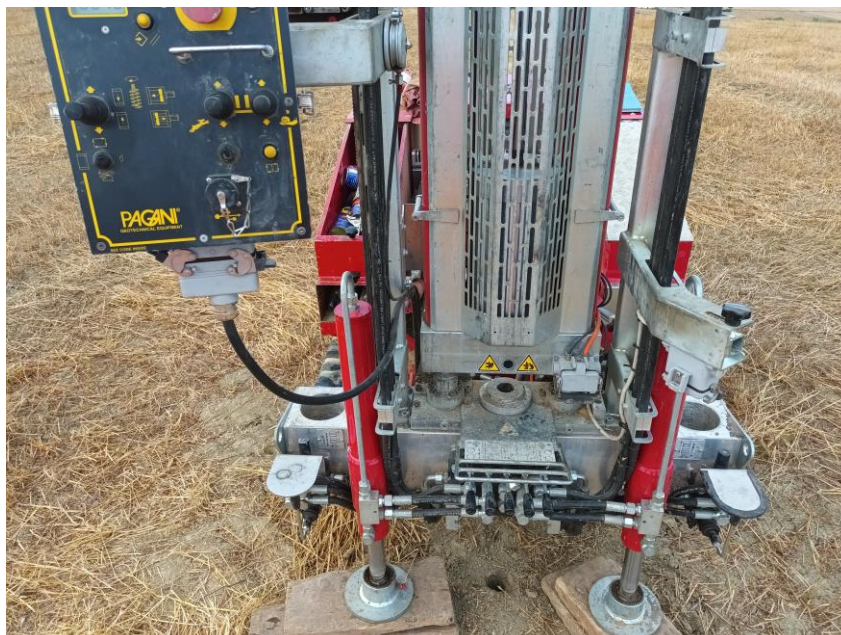
Postazione dell'indagine DPSH06
