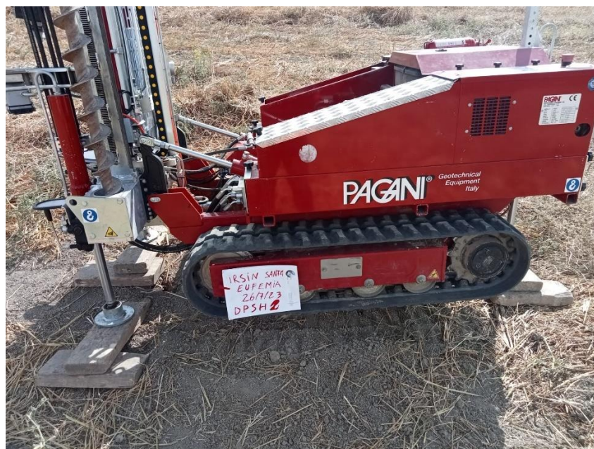
Postazione dell'indagine DPSH02
