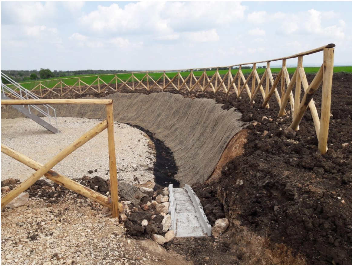
Figura 11_ Manutenzione cunette idrauliche e versanti – Impianto Eolico di Proprietà – Basilicata
