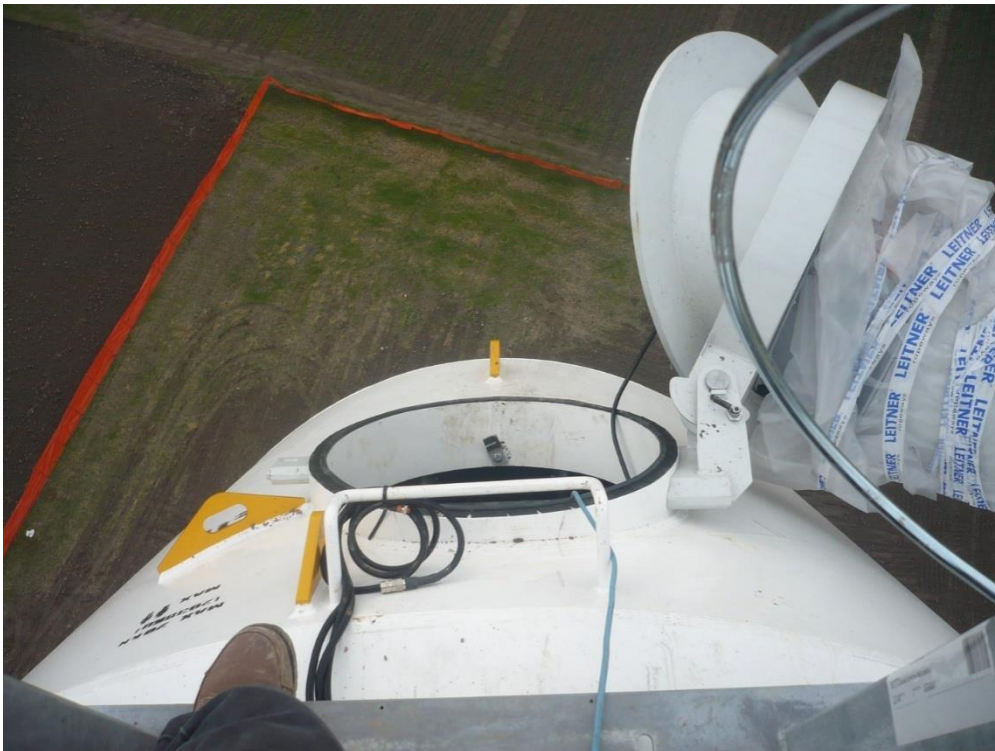
Figura 3_ Attività di controllo esterne alla navicella – Parco Eolico di Proprietà - Puglia
