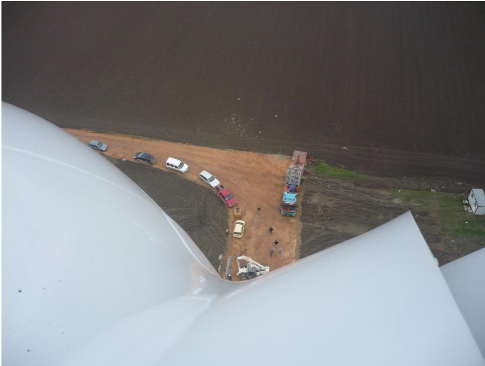
Figura 2_ Attività di controllo esterne alla navicella – Parco Eolico di Proprietà - Puglia
