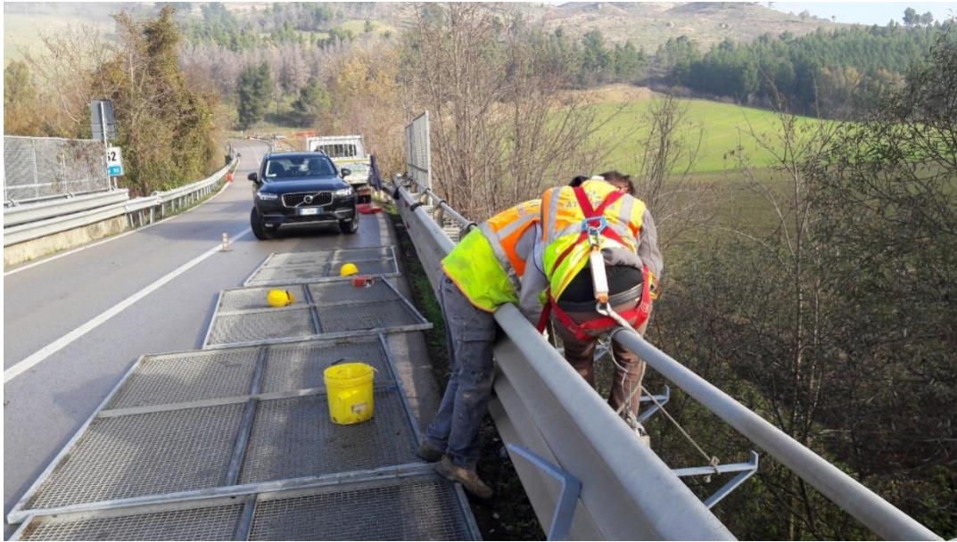
Figura 12_ Sostituzione canaline esterne ammalorate – Impianto Eolico di Proprietà – Basilicata
