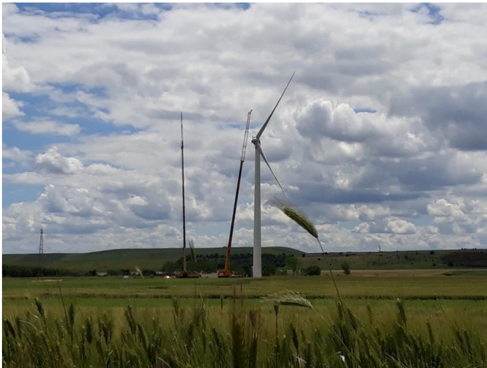
Figura 15_ Intervento sostituzione ruota dentata pala – Impianto Eolico di Proprietà – Puglia
