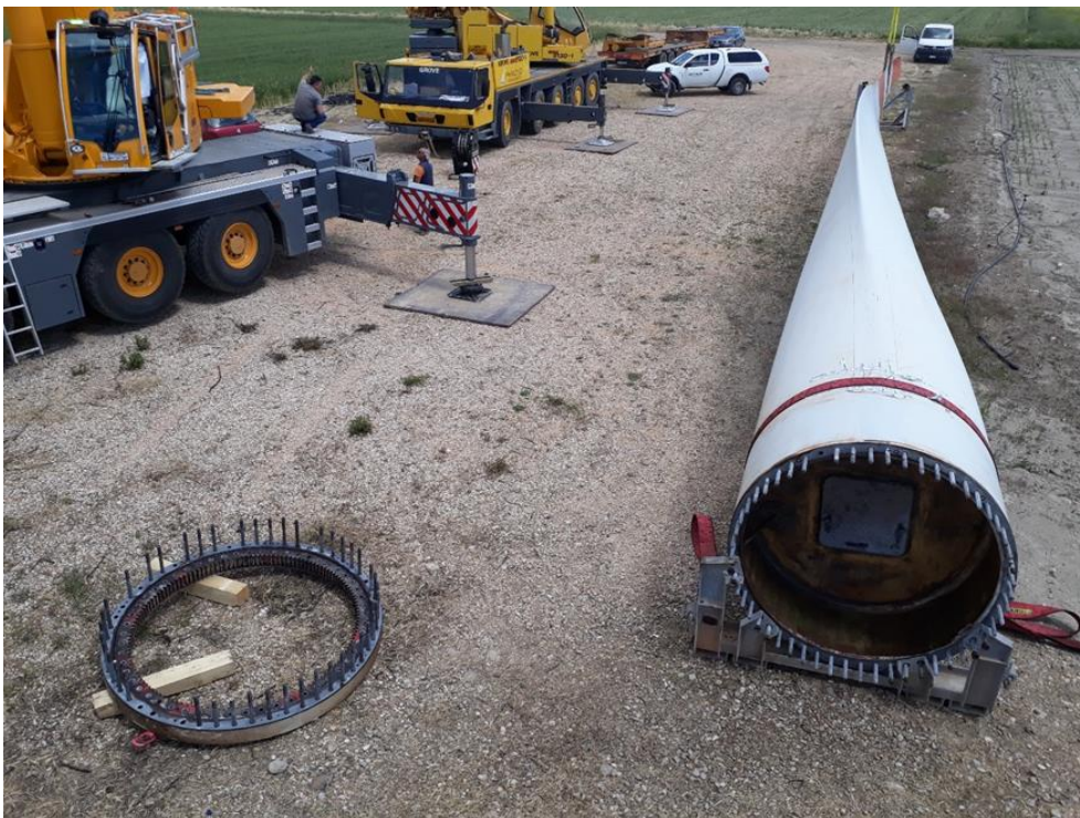
Figura 16_ Intervento sostituzione ruota dentata pala – Impianto Eolico di Proprietà – Puglia
