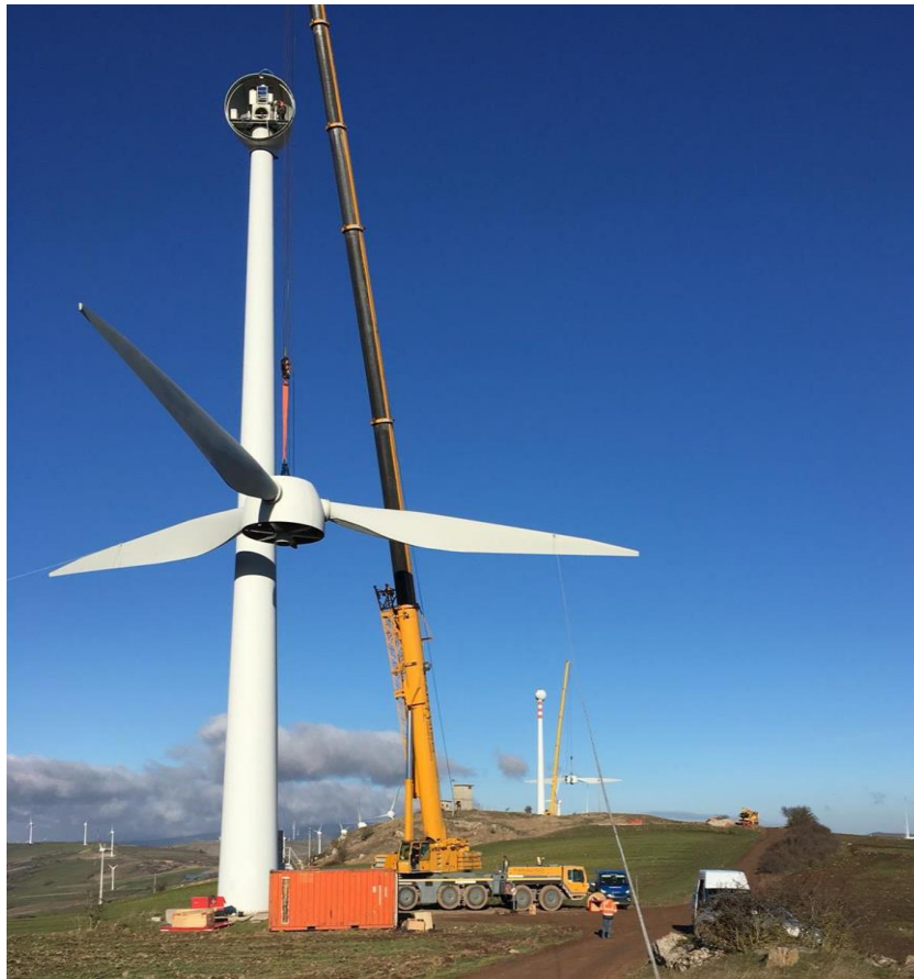
Figura 2: smontaggio torre e rotore
