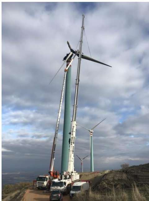
Figura 1: rimozione eliche e mozzo
