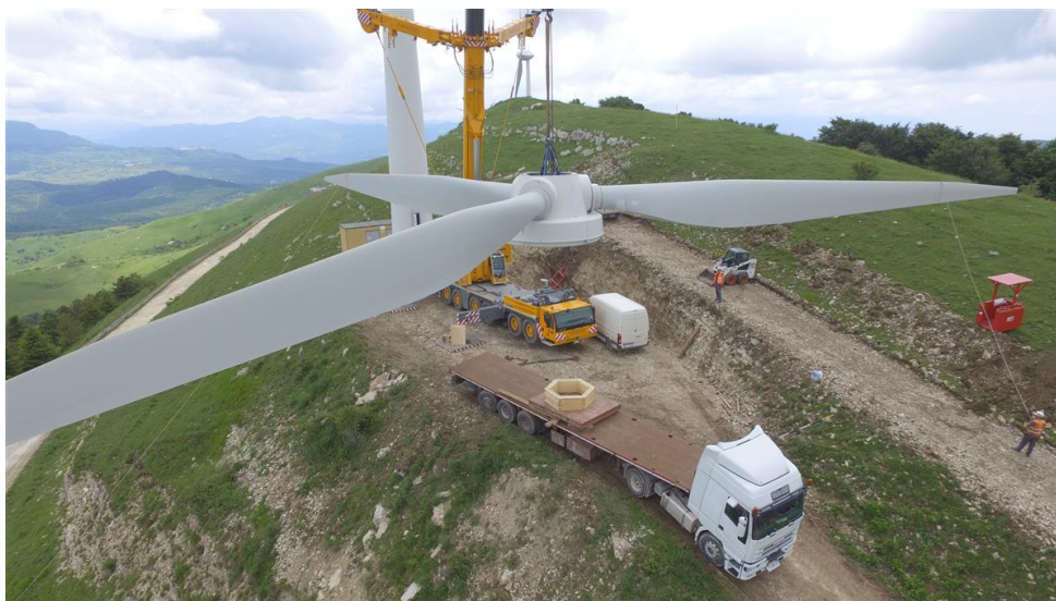
Figura 3: particolare smontaggio rotore
