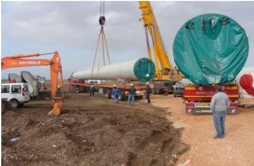
Figura 4: elementi torre smontata da trasportare a centri di recupero
