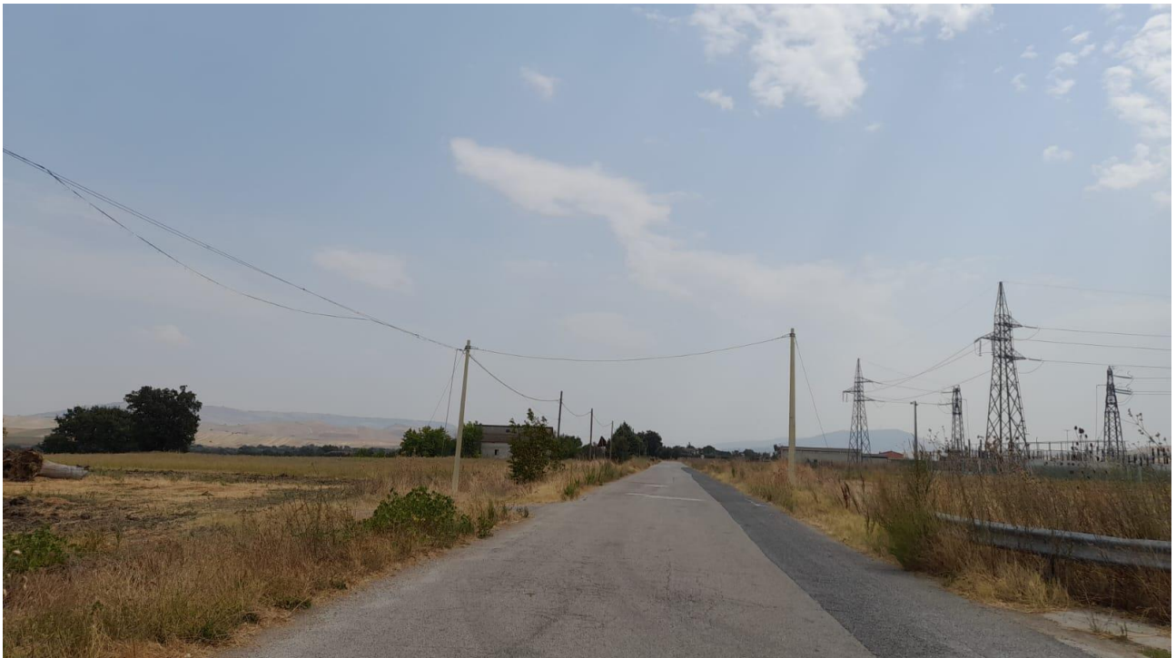
Figura 12_Accesso sottostazione "Terna" in agro di Oppido Lucano
