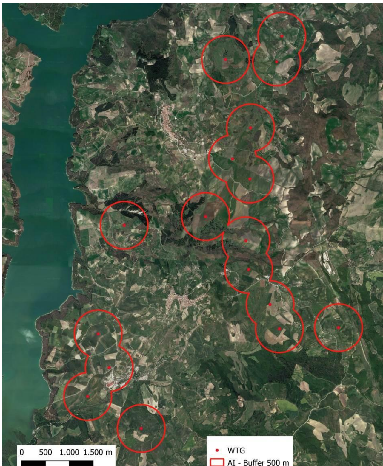
Figura 6 – Mappa di inquadramento --Localizzazione WTG e Area di Intervento (AI) buffer 500 m da WTG
