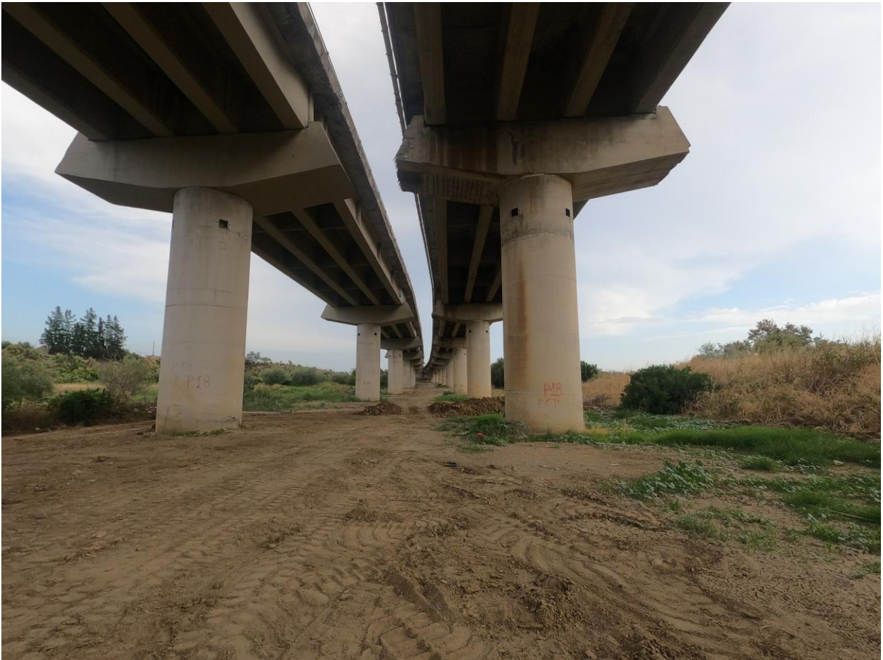
Figura 8.1. Canaletta in VTR ancorata al cordolo lato interno per l'intero sviluppo del viadotto (vista dal basso)
