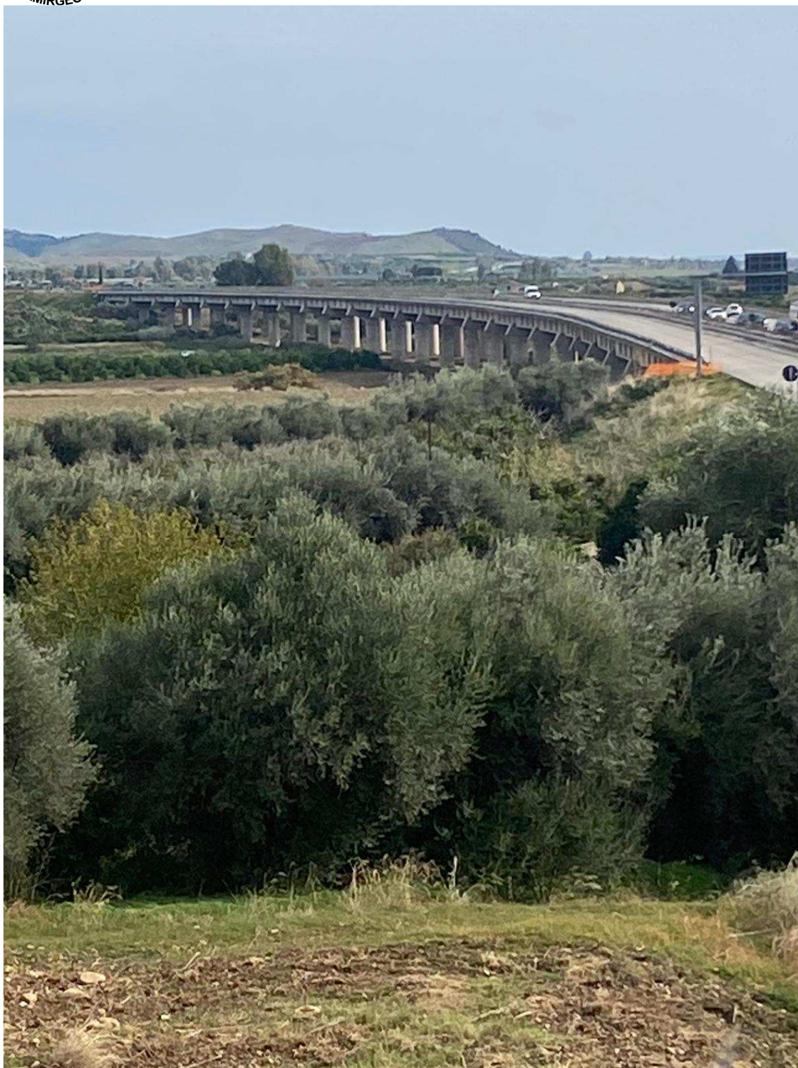
FOTO N. 1 - PANORAMICA DEL VIADOTTO ALFIO
