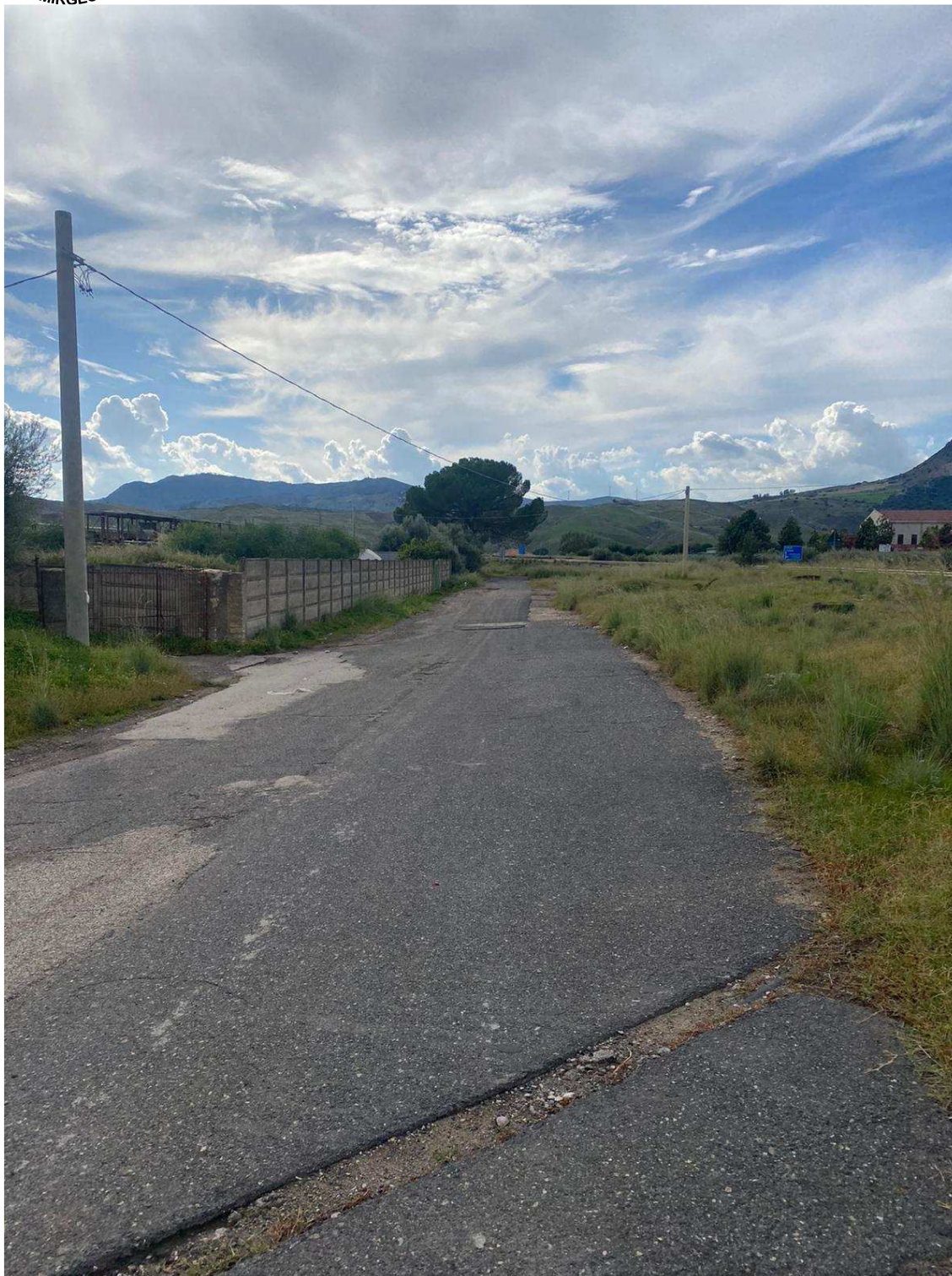
FOTO N. 3 - STRADA DI CANTIERE ASFALTATA REALIZZATA PER LA REALIZZAZIONE DEL VIADOTTO FERROVIARIO E CHE SARA' UTILIZZATA ANCHE PER IL PRESENTO PROGETTO
