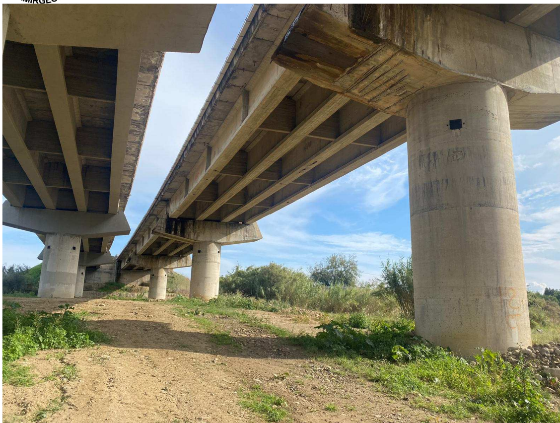
FOTO N. 6 - PISTA DI CANTIERE REALIZZATA PER LA COSTRUZIONE DELL'AUTOSTRADA ED OGGI UTILIZZATA PER LE OPERE DI MANUTENZIONE E DOMANI COME PISTA DI CANTIERE PER I LAVORI DI CUI AL PRESENTE PROGETTO
