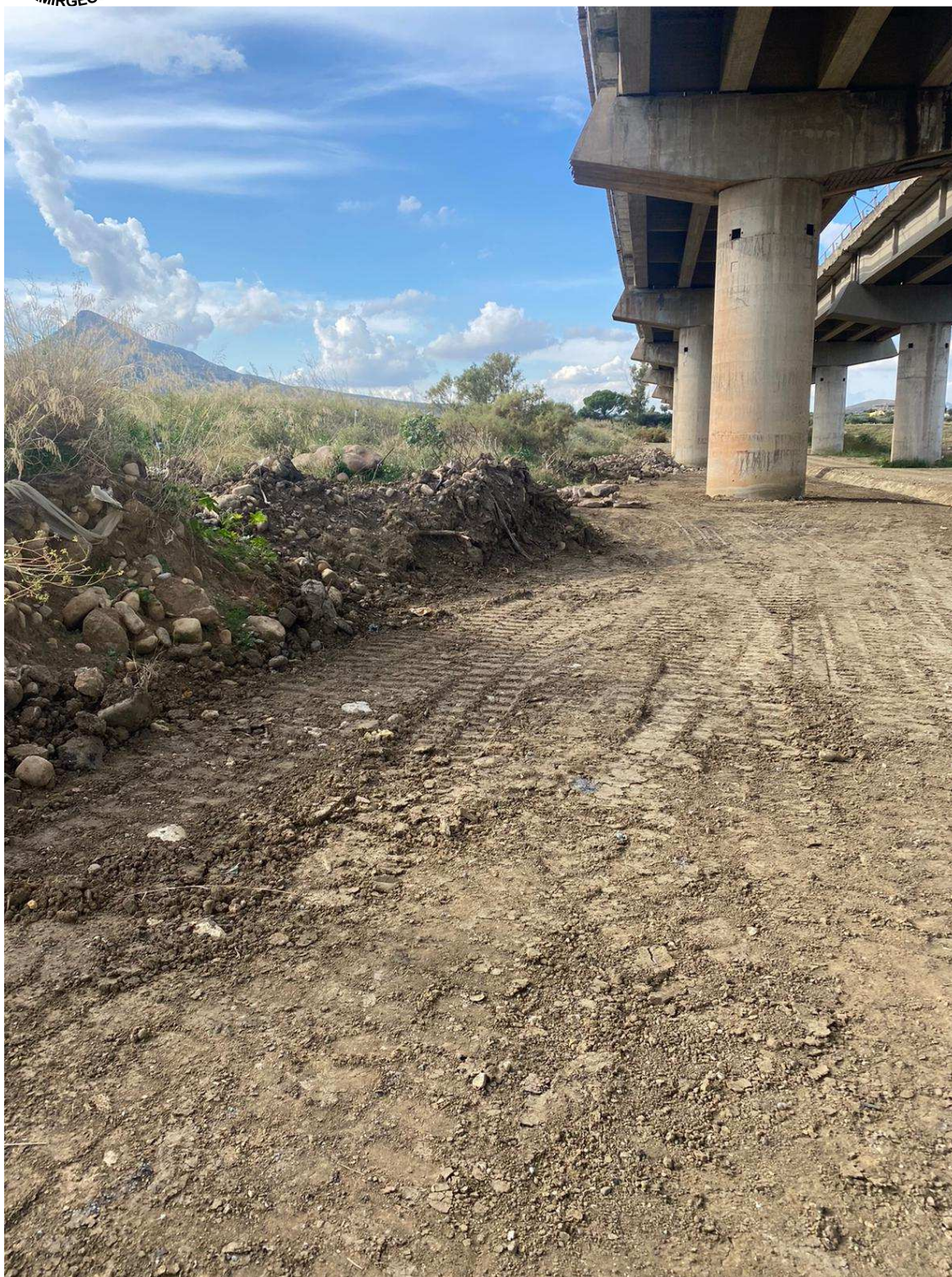
FOTO N. 9 – IN QUESTO TRATTO E' PREVISTA UNA PISTA LATERALE DI CANTIERE ALL'ALTEZZA DELLE PILE N. 11-12-13. COME VISIBILE L'AREA NON RIVESTE ALCUN INTERESSE NATURALISTICO MA SARA' RINATURALIZZATA A FINE LAVORI CON ESSENZE DI PREGIO
