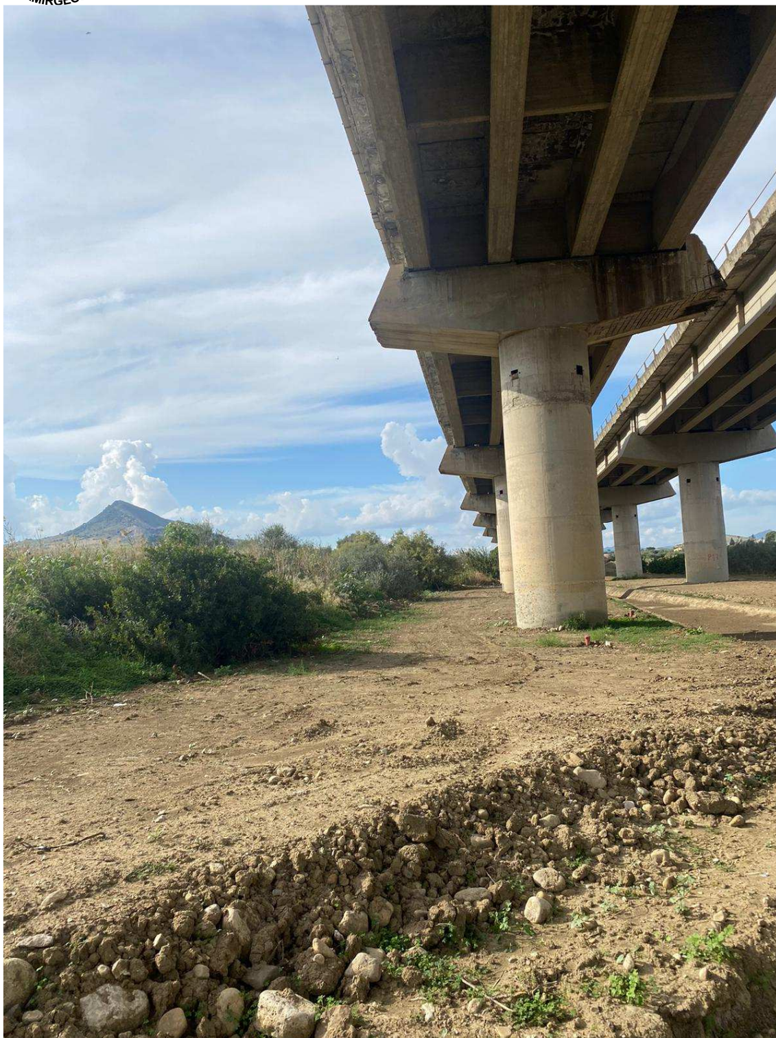
FOTO N. 4 – PISTA DI CANTIERE REALIZZATA PER LA COSTRUZIONE DELL'AUTOSTRADA ED OGGI UTILIZZATA PER LE OPERE DI MANUTENZIONE E DOMANI COME PISTA DI CANTIERE PER I LAVORI DI CUI AL PRESENTE PROGETTO
