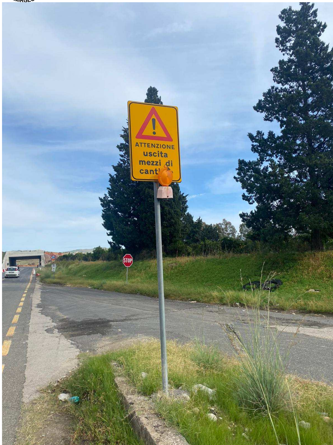
FOTO N. 2 - INGRESSO STRADA DI CANTIERE ASFALTATA REALIZZATA PER LA REALIZZAZIONE DEL VIADOTTO FERROVIARIO E CHE SARA' UTILIZZATA ANCHE PER IL PRESENTO PROGETTO
