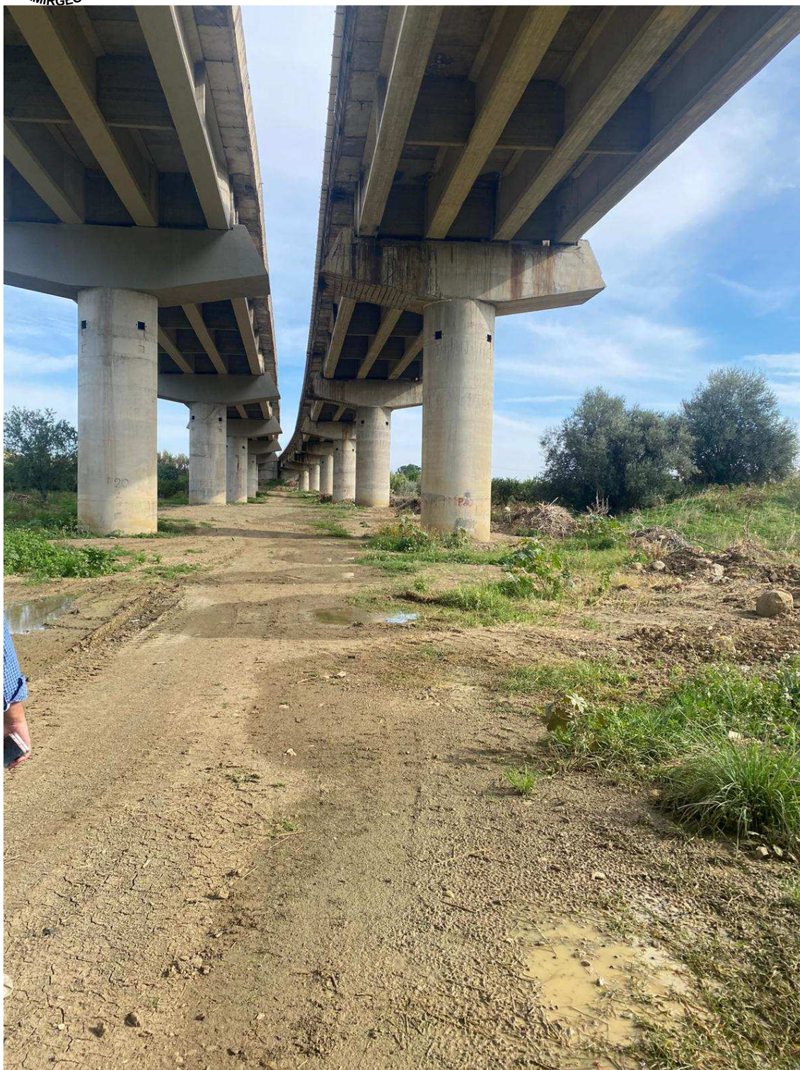
FOTO N. 5 – PISTA DI CANTIERE REALIZZATA PER LA COSTRUZIONE DELL'AUTOSTRADA ED OGGI UTILIZZATA PER LE OPERE DI MANUTENZIONE E DOMANI COME PISTA DI CANTIERE PER I LAVORI DI CUI AL PRESENTE PROGETTO
