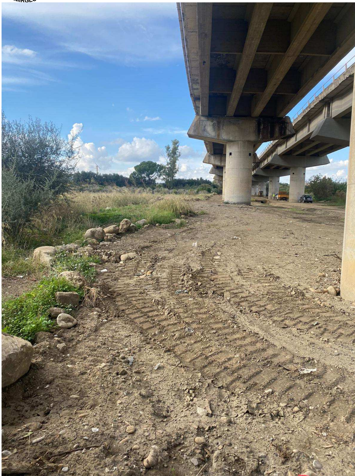
FOTO N. 11 – PISTA DI CANTIERE REALIZZATA PER LA COSTRUZIONE DELL'AUTOSTRADA ED OGGI UTILIZZATA PER LE OPERE DI MANUTENZIONE E DOMANI COME PISTA DI CANTIERE PER I LAVORI DI CUI AL PRESENTE PROGETTO
