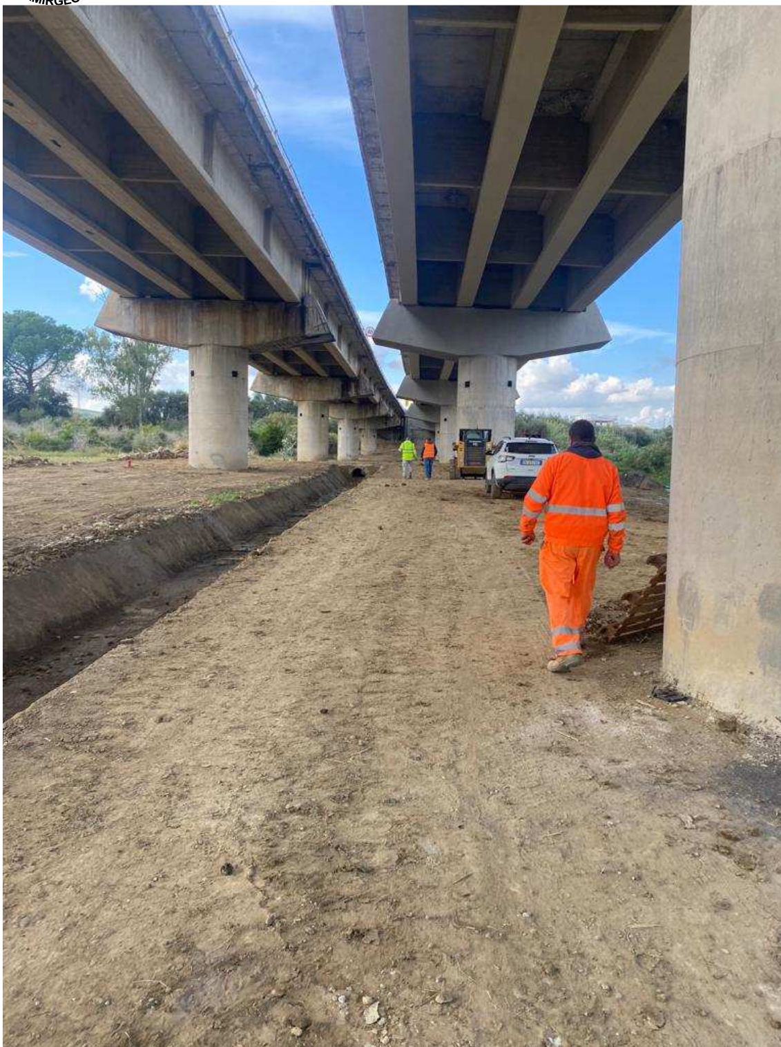
FOTO N. 14 - PISTA DI CANTIERE REALIZZATA PER LA COSTRUZIONE DELL'AUTOSTRADA ED OGGI UTILIZZATA PER LE OPERE DI MANUTENZIONE E DOMANI COME PISTA DI CANTIERE PER I LAVORI DI CUI AL PRESENTE PROGETTO
