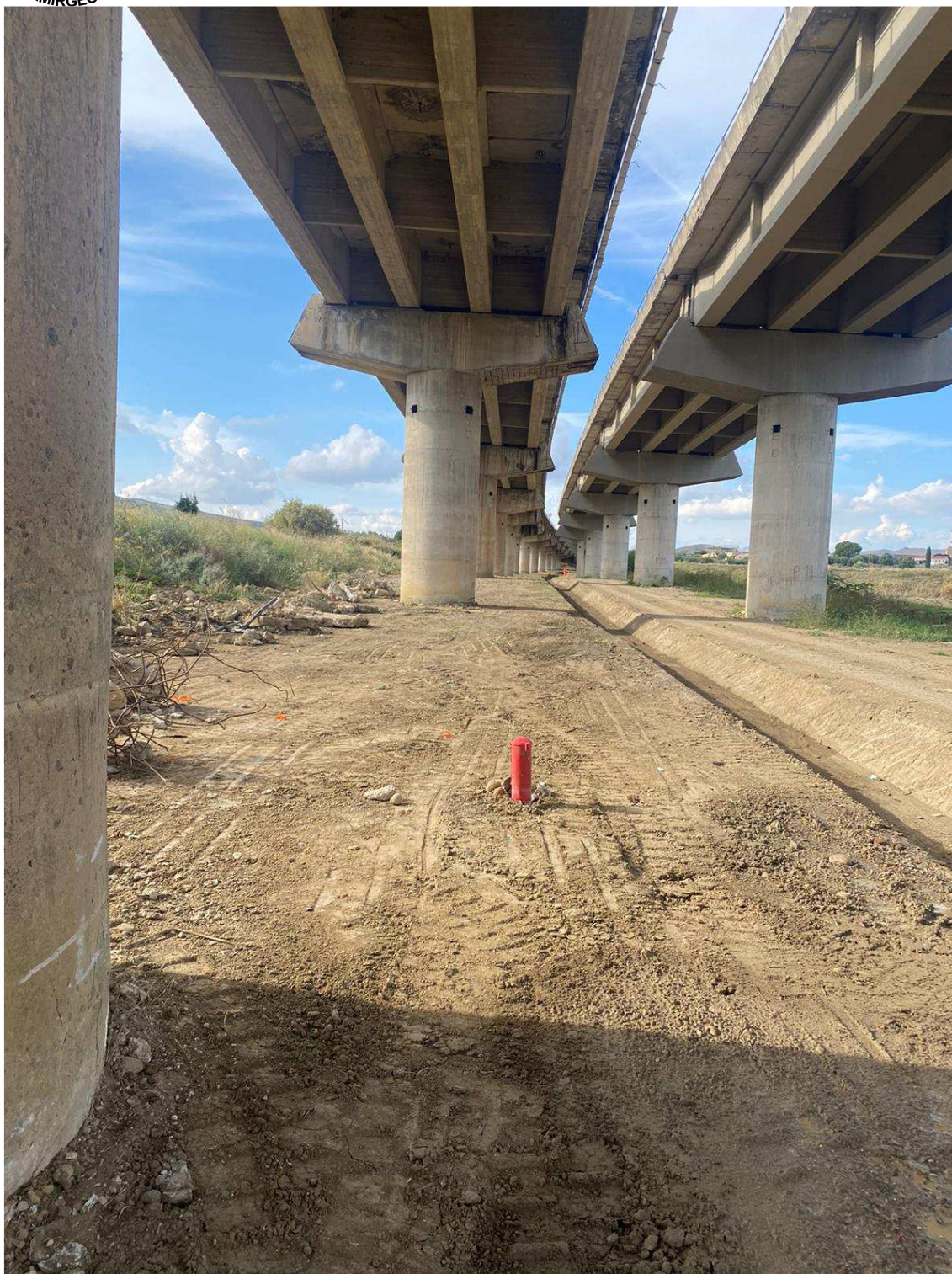
FOTO N. 10 – PISTA DI CANTIERE REALIZZATA PER LA COSTRUZIONE DELL'AUTOSTRADA ED OGGI UTILIZZATA PER LE OPERE DI MANUTENZIONE E DOMANI COME PISTA DI CANTIERE PER I LAVORI DI CUI AL PRESENTE PROGETTO
