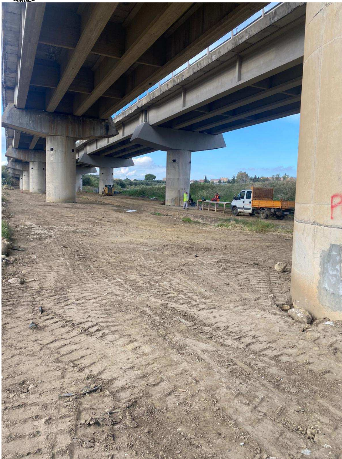
FOTO N. 12 - PISTA DI CANTIERE REALIZZATA PER LA COSTRUZIONE DELL'AUTOSTRADA ED OGGI UTILIZZATA PER LE OPERE DI MANUTENZIONE E DOMANI COME PISTA DI CANTIERE PER I LAVORI DI CUI AL PRESENTE PROGETTO
