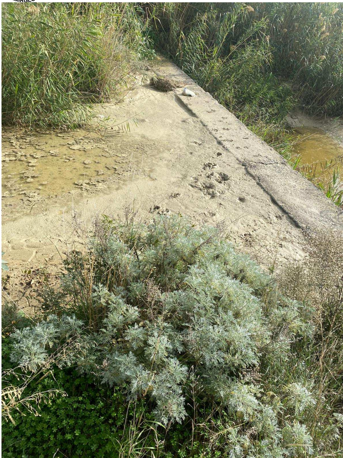
FOTO N. 8 – QUESTO E' IL CORSO D'ACQUA CHE SARA' ATTRAVERSATO DAL GUADO PROVVISORIO. SI NOTI LA PRESENZA DI UNA BRIGLIA IN CEMENTO ESISTENTE. NON SI INDIVIDUANO SPECIE DI INTERESSE. A FINE LAVORI IL GUADO SARA' DEMOLITO E L'AREA RINATURALIZZATA CON ESSENZE DI PREGIO
