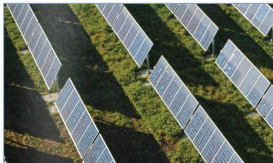
FIGURA 5 : FOTO TIPO TRACKERS AD ASSE VARIABILE
