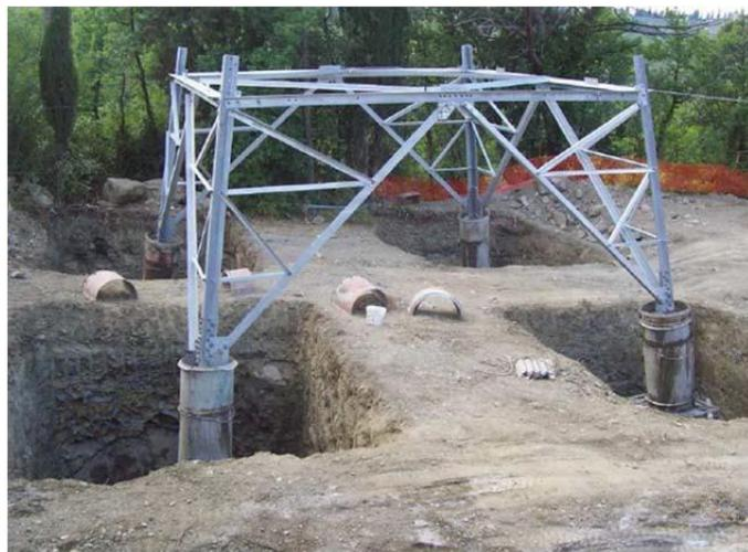
La fondazione dei sostegni a traliccio della linea aerea oggetto di intervento è formata da quattro plinti isolati, uno per ciascun montante, posti ad una distanza pari all'interasse dei montanti del traliccio stesso (cfr. immagine sopra).
