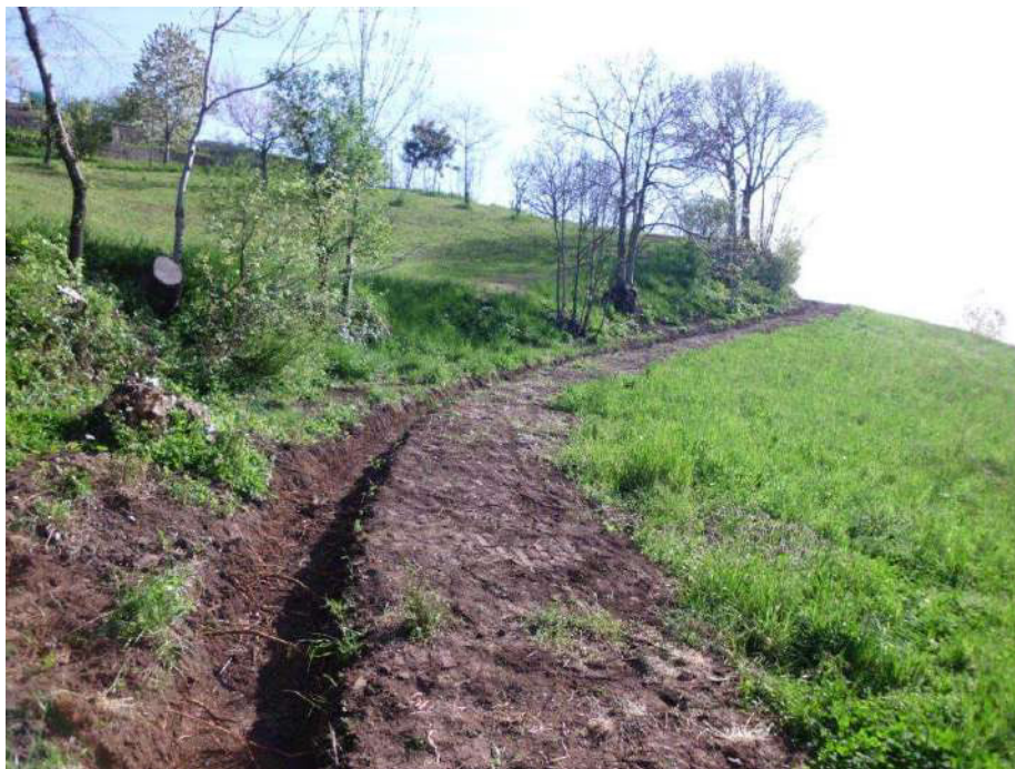
Figura 53. Particolare ipotesi regimentazione aree di impianto con fossi di guardia "naturali"
