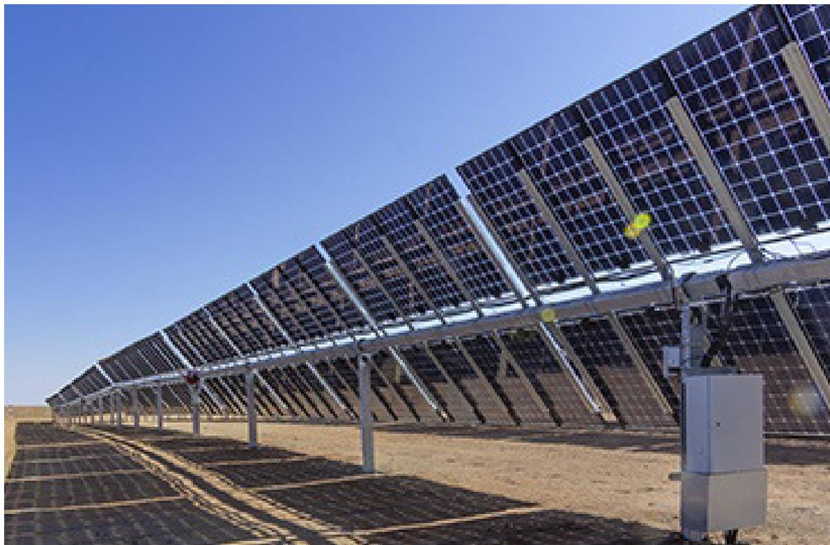
*Figura 7: Sistema tracker - inseguitore solare- tipo monoassiale single portrait*
